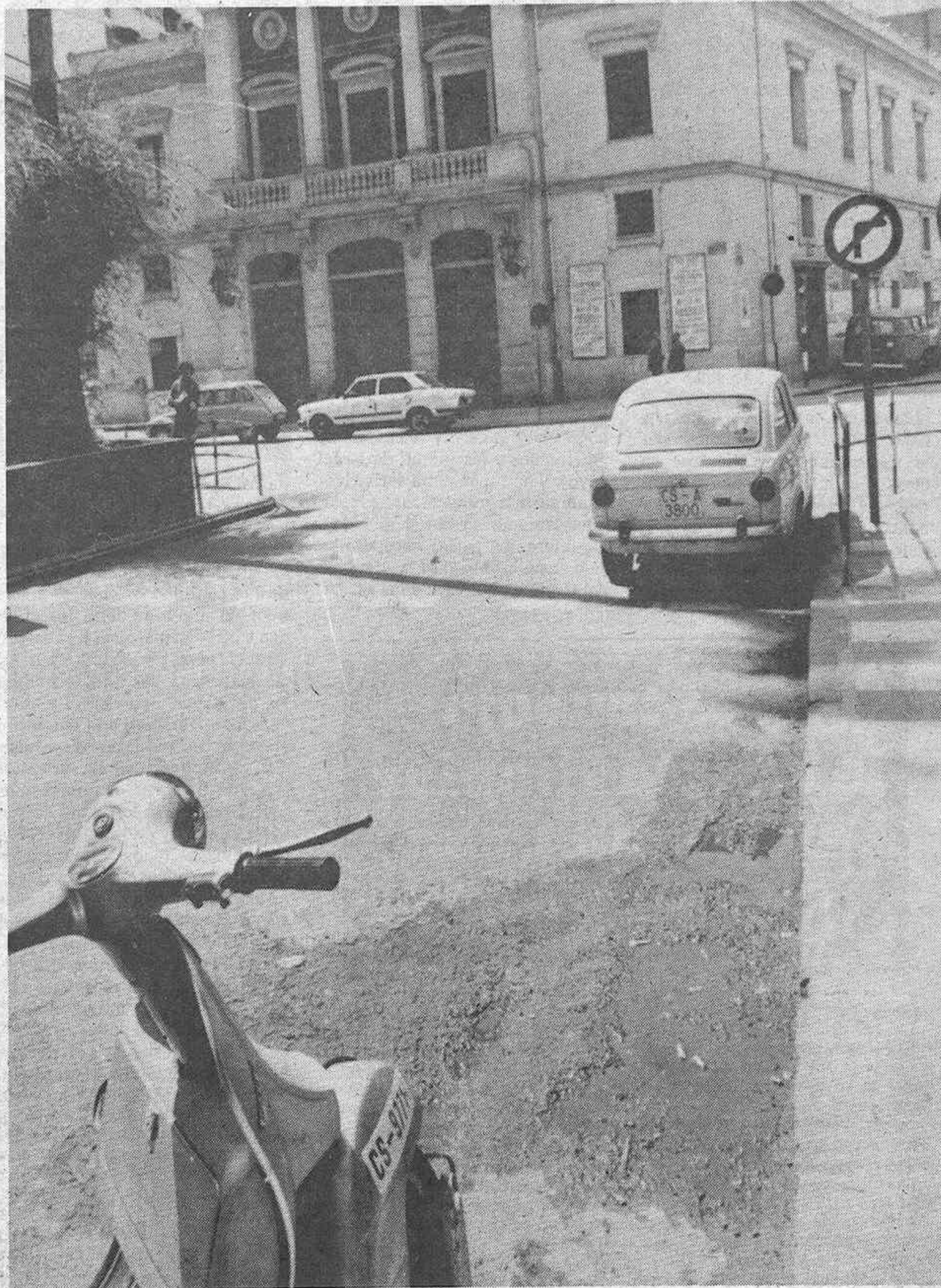
Entre las obras que se financian con la ampliación del presupuesto de inversiones, figura la repavimentación de la plaza de la Paz y otras vías del centro y ensanche.
