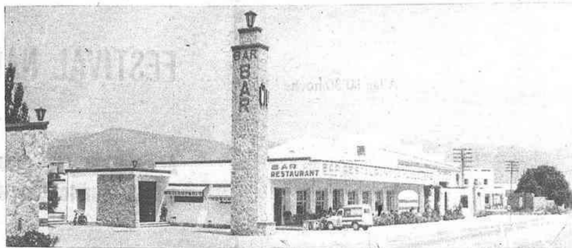
Vista general de las instalaciones de Bar Restaurant y Estación de engrase y lavado de vehículos de la Cooperativa de Transportes (CO-TRANS-CA)
