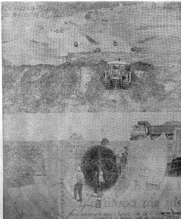
ASCO (Tarragona).— He aquí un aspecto de los trabajos de movimiento de tierras y explanación para la construcción de la central nuclear de Ascó, sobre la margen derecha del Ebro. Dicha central estará compuesta de dos unidades de 930 MW eléctricas cada una, y está previsto que la primera de ellas entre en funcionamiento a mediados de 1977. Un aspecto también de la construcción del colector de 450 metros de largo y 380 de diámetro.—(Foto Cifra Gráfica).
