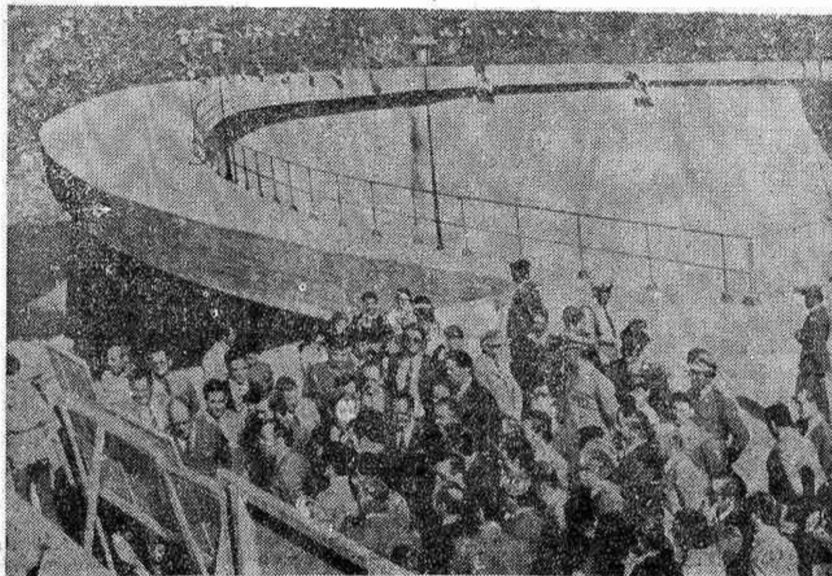
LAS PALMAS. — El Ministro de Obras Públicas ha inaugurado en Las Palmas la presa de Soria, que es la más importante del archipiélago canario. En la foto, el Ministro recibe las explicaciones de los técnicos que han intervenido en la construcción de la obra
