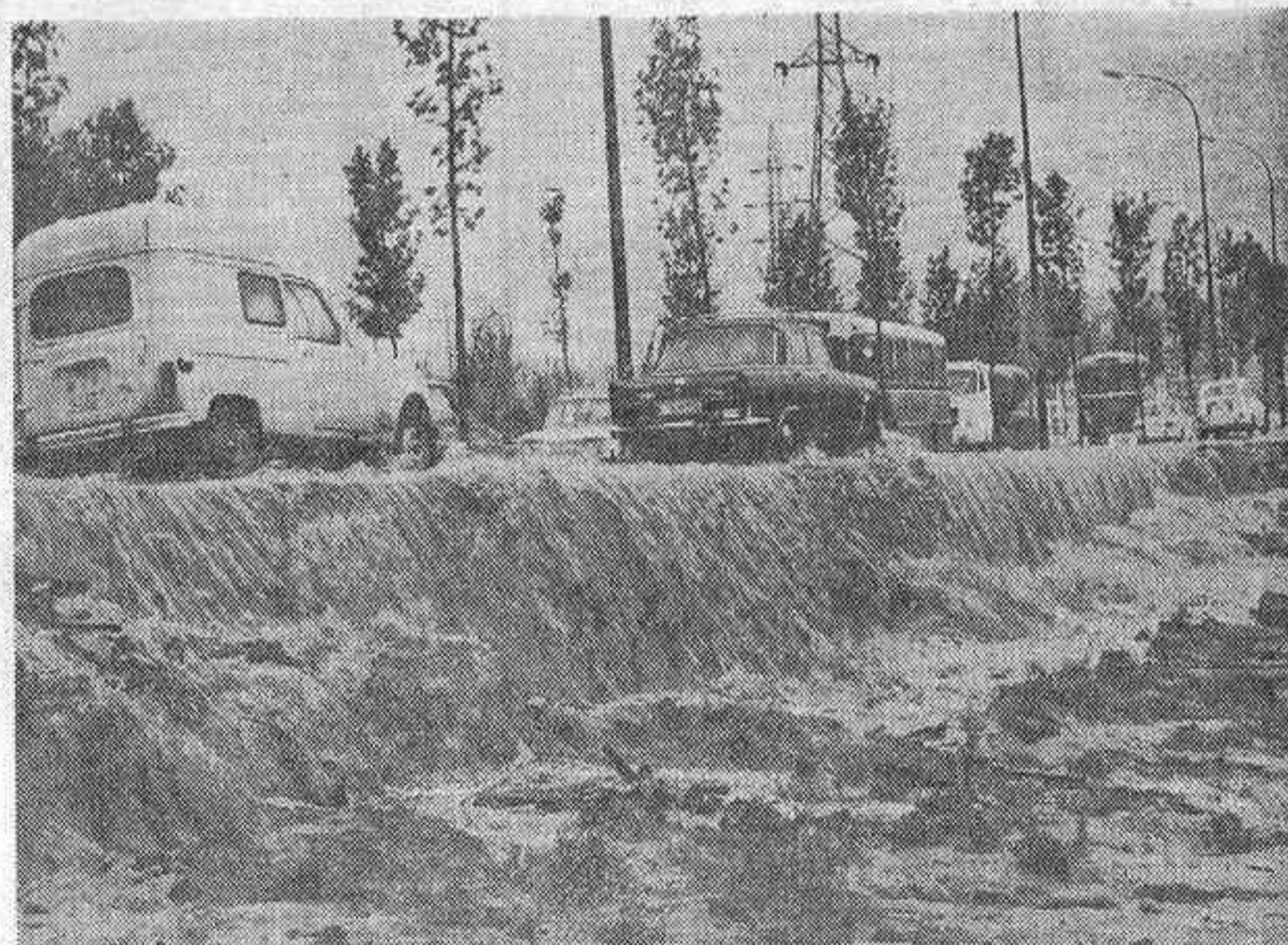
MADRID. — Una de las zonas de Madrid más afectadas por las lluvias de estos días ha sido la del barrio del Pilar, algunos de cuyos accesos quedaron convertidos en verdaderos ríos, que, en ciertos momentos, se desbordaban como verdaderas cascadas. — (Telefoto CIFRA GRAFICA)
