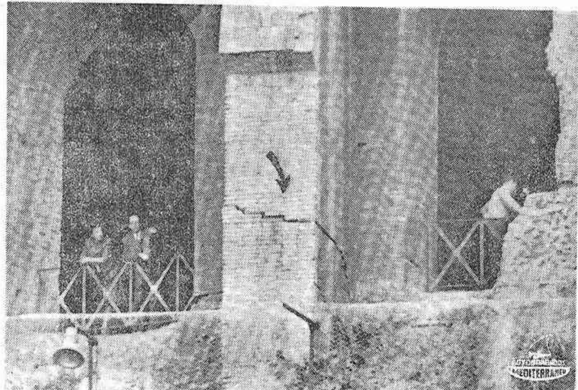
ROMA. — Dos ingenieros examinan bajo uno de los arcos del Palacio Tiberius, de Roma, uno de los pilares (marcado con una flecha) en el que se ha producido una grieta, y que ha obligado a suspender el programa "Sonido y Luz" que venía celebrándose en el Forum romano. — (Telefoto CIFRA GRAFICA)
