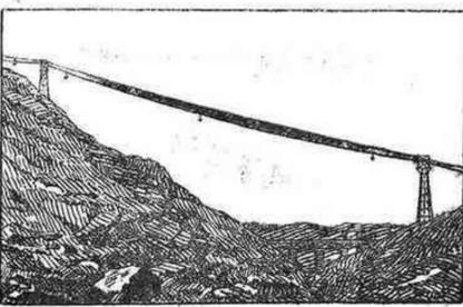
Instalación de funiculares aéreos para el transporte de frutos, materiales de empaque, limpieza de embalses etc.
