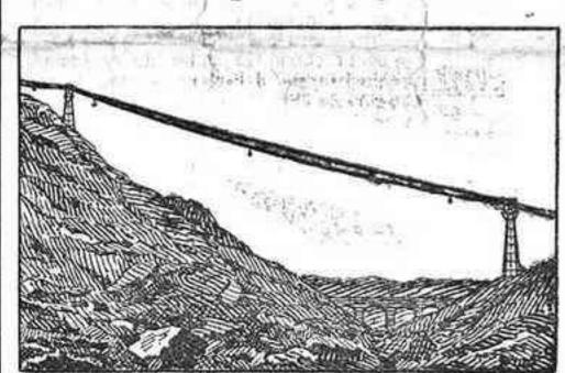
Instalación de funiculares aéreos para el transporte de frutos, materiales de empaque, limpieza de embalses
