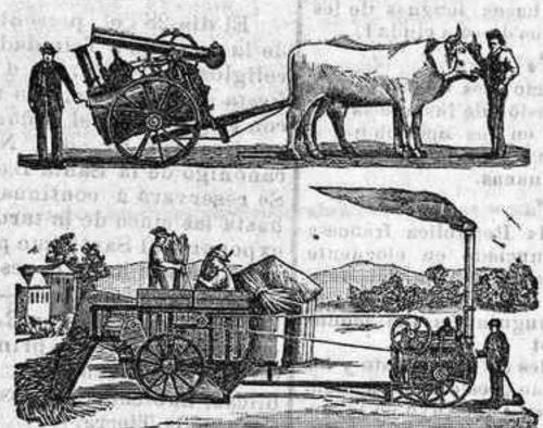
Rendimiento máximo con gasto reducidode combustible. Construccion muy sólida, de poco peso y fácil transporte, a un sobre terrenos muy quebrados. Locomóviles puestas en presión en dec e minutos, mediante un nuevo aparato patentizado. marata mara l'and atamoratif a amazone ashia l'
