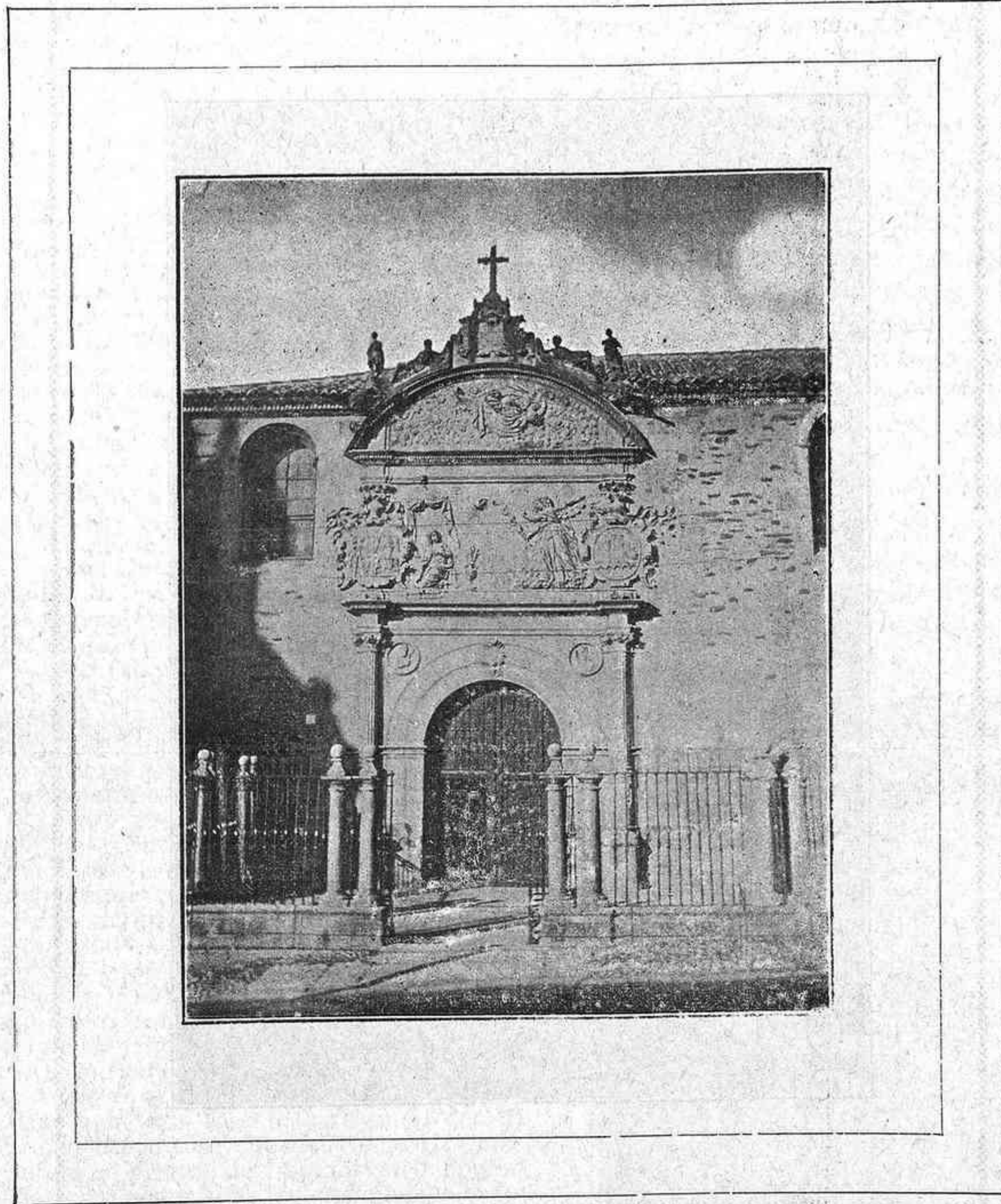
FACHADA DE LA IGLESIA DE MM. CARMELITAS
