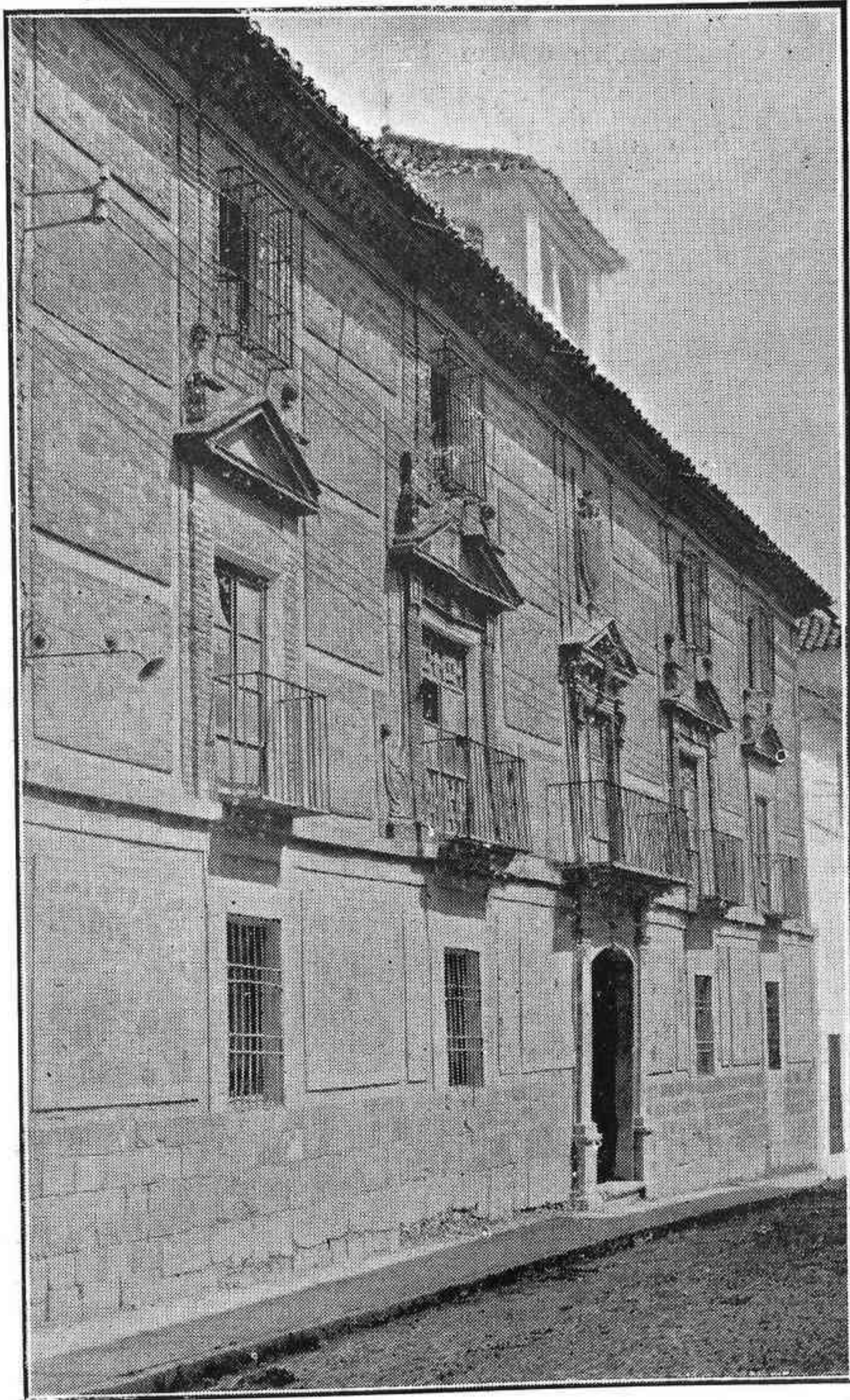
Fachada principal del Colegio
