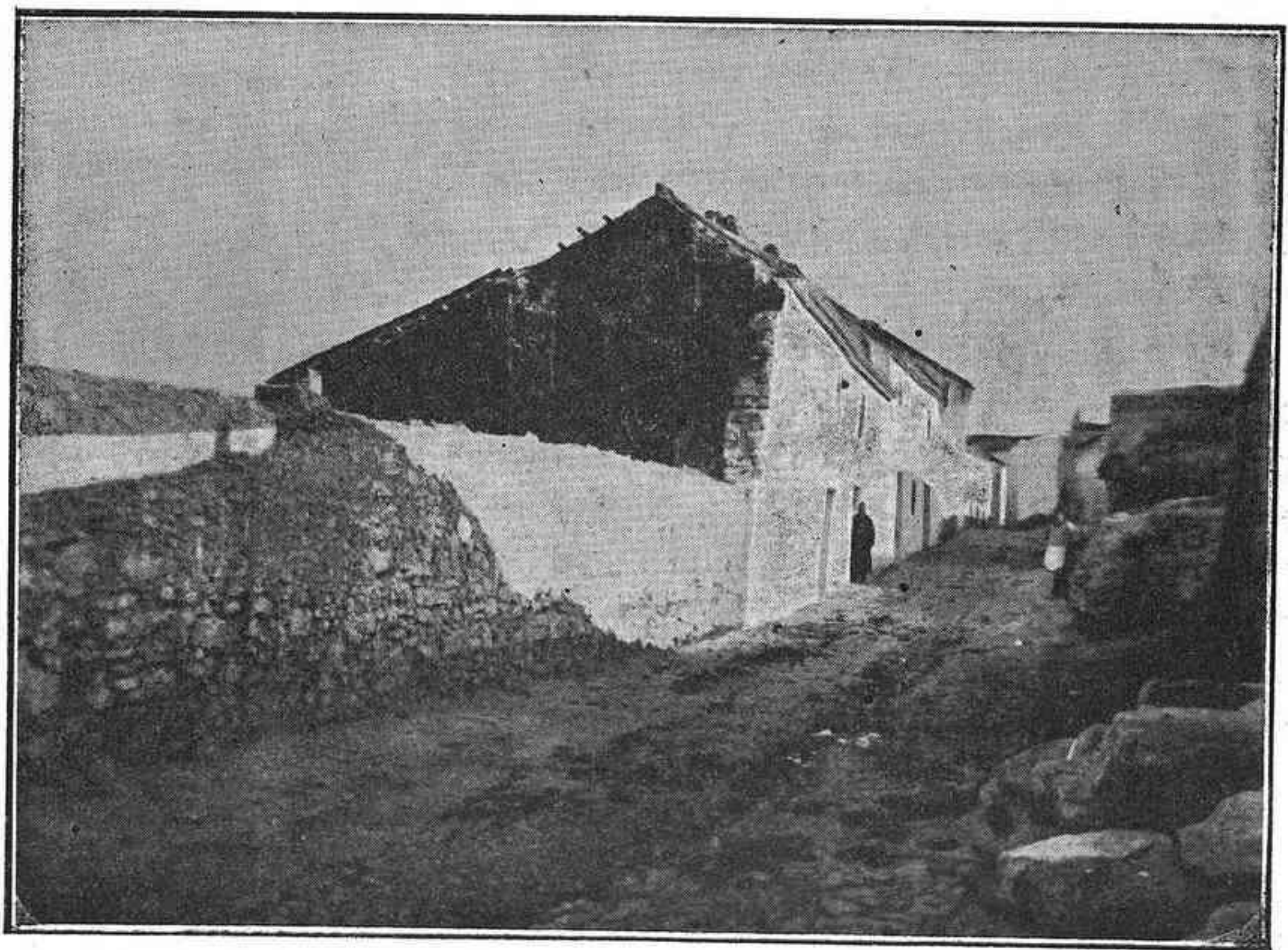
MONTILLA.—Calle de San Miguel.—Desplome de muros del Norte. Movimiento intenso vertical, oscilación dominante Sur a Norte.
