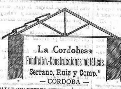
Armaduras metálicas para eu brir con teja plana, ladrillo por tabla y teja de rueda.
