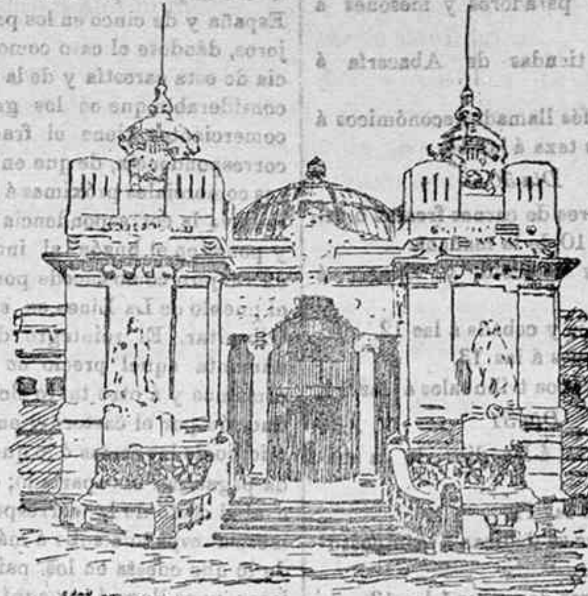
Fachada y puerta de entrada al palacio de la Exposición
