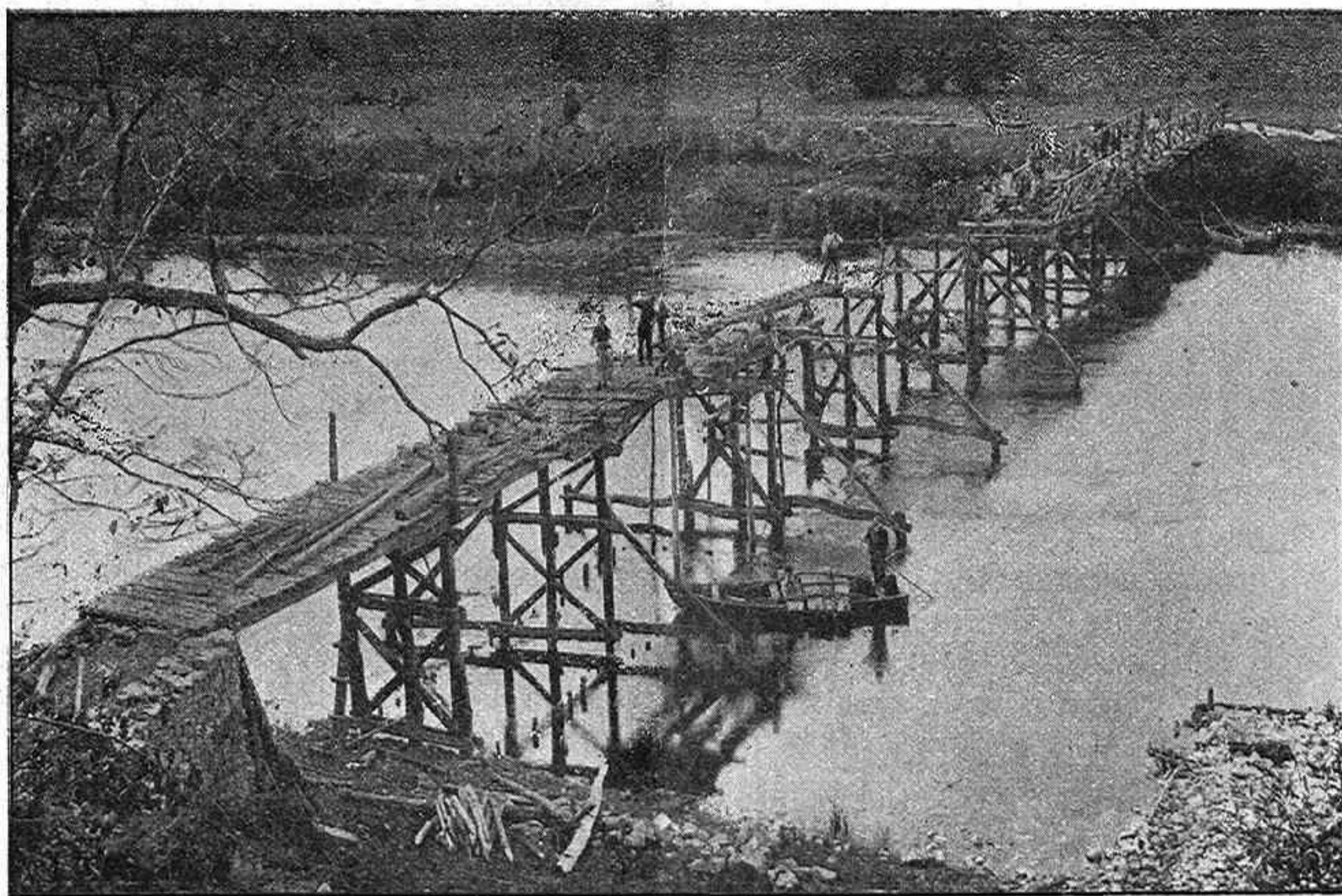
Puente de madera que los vecinos de Quinzanas construyen sobre el río Narcea.
