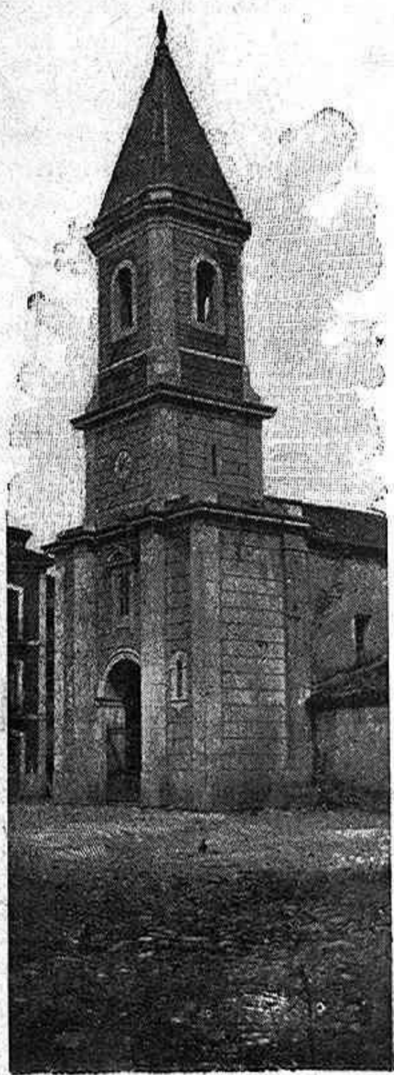
Torre de la iglesia de Muros
