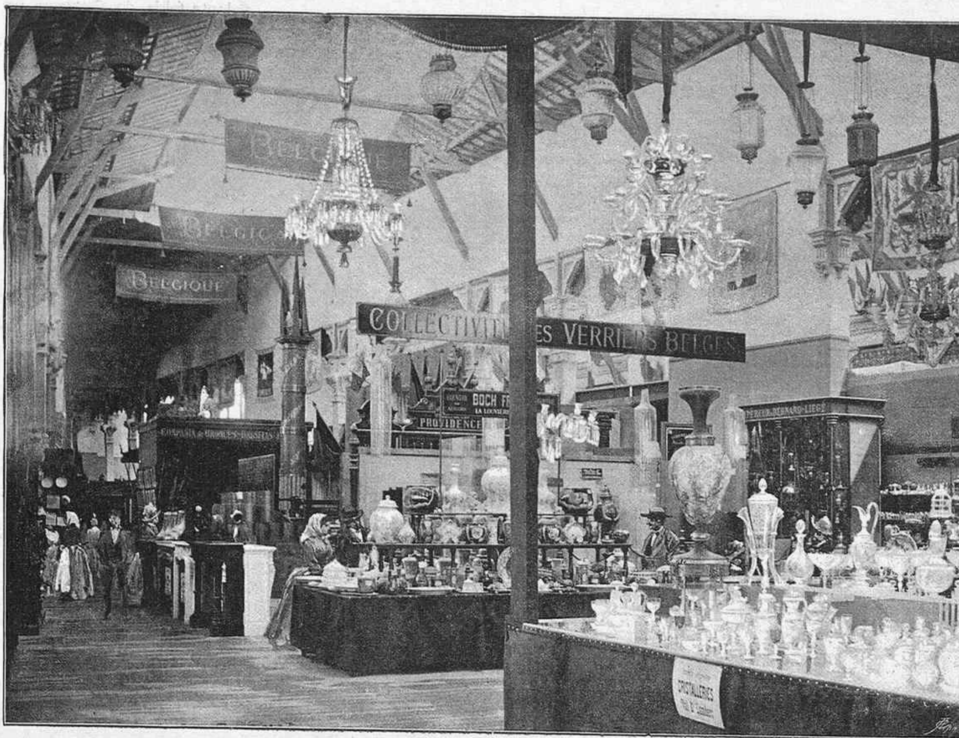
Exposición Universal de Barcelona. - INSTALACIONES BELGAS
