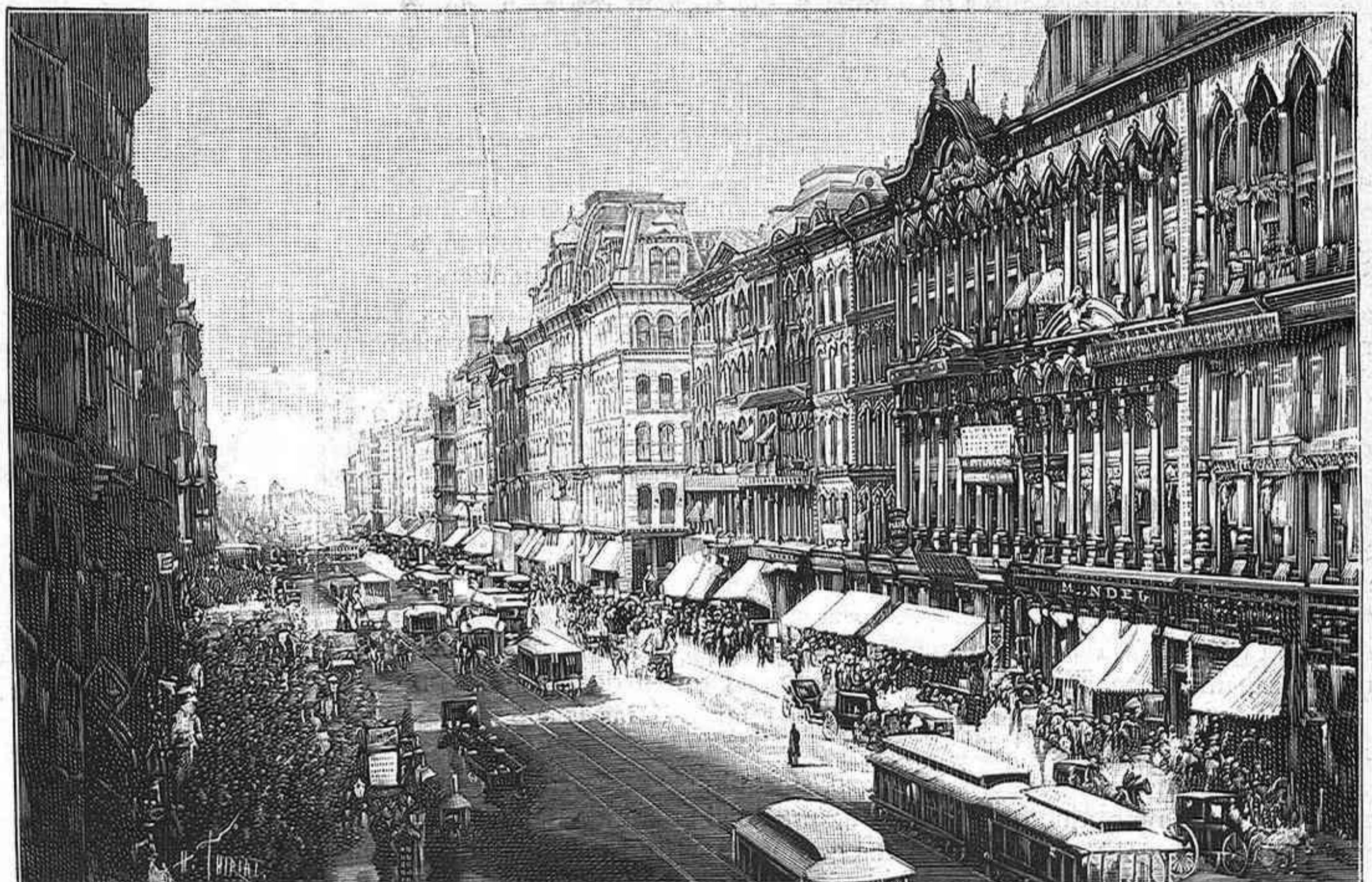
Fig. 2 - State Street, en Chicago. (De una fotografía.)
