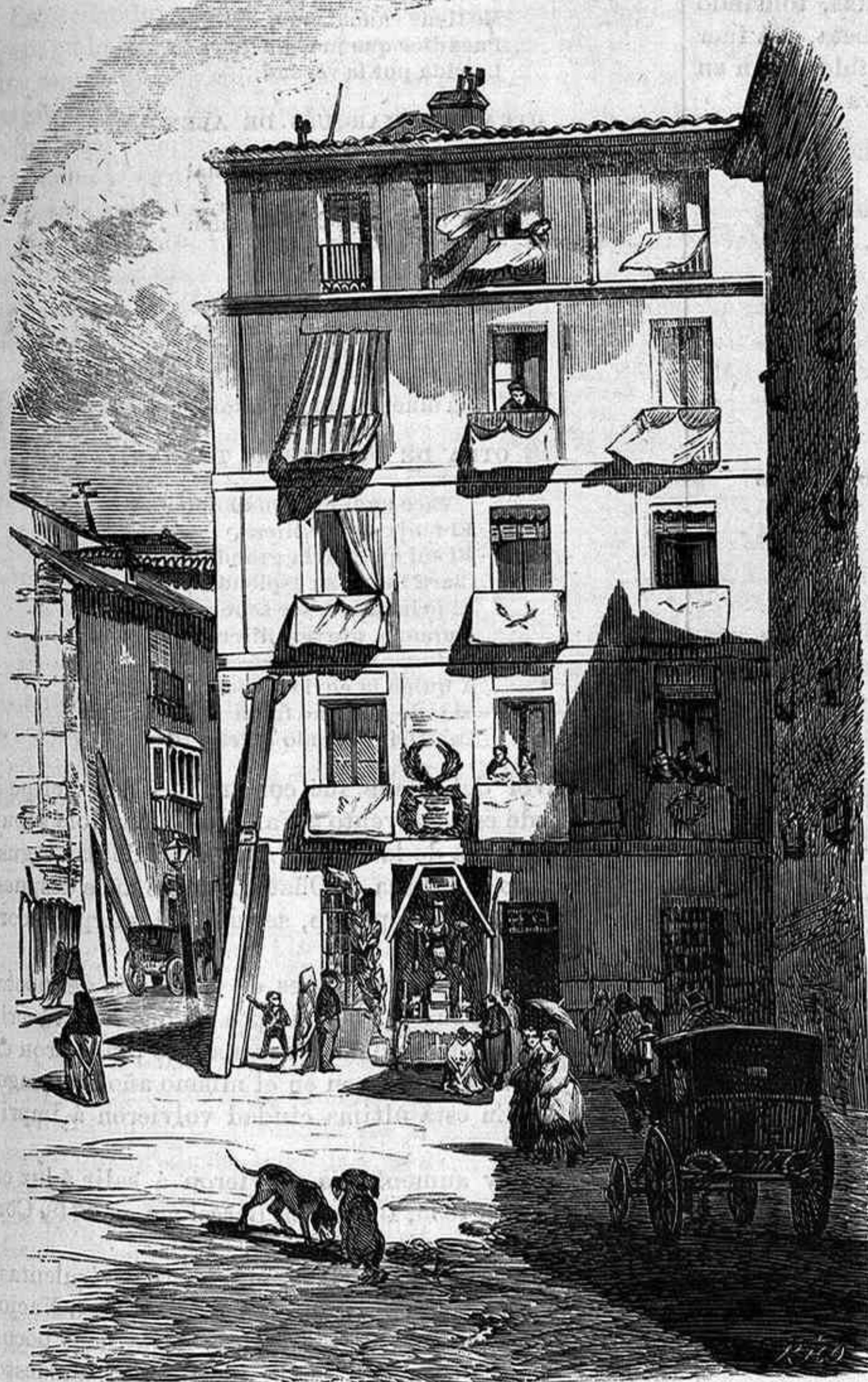
CASA DE DAOIZ EN LA CALLE DE LA TERNERA.
