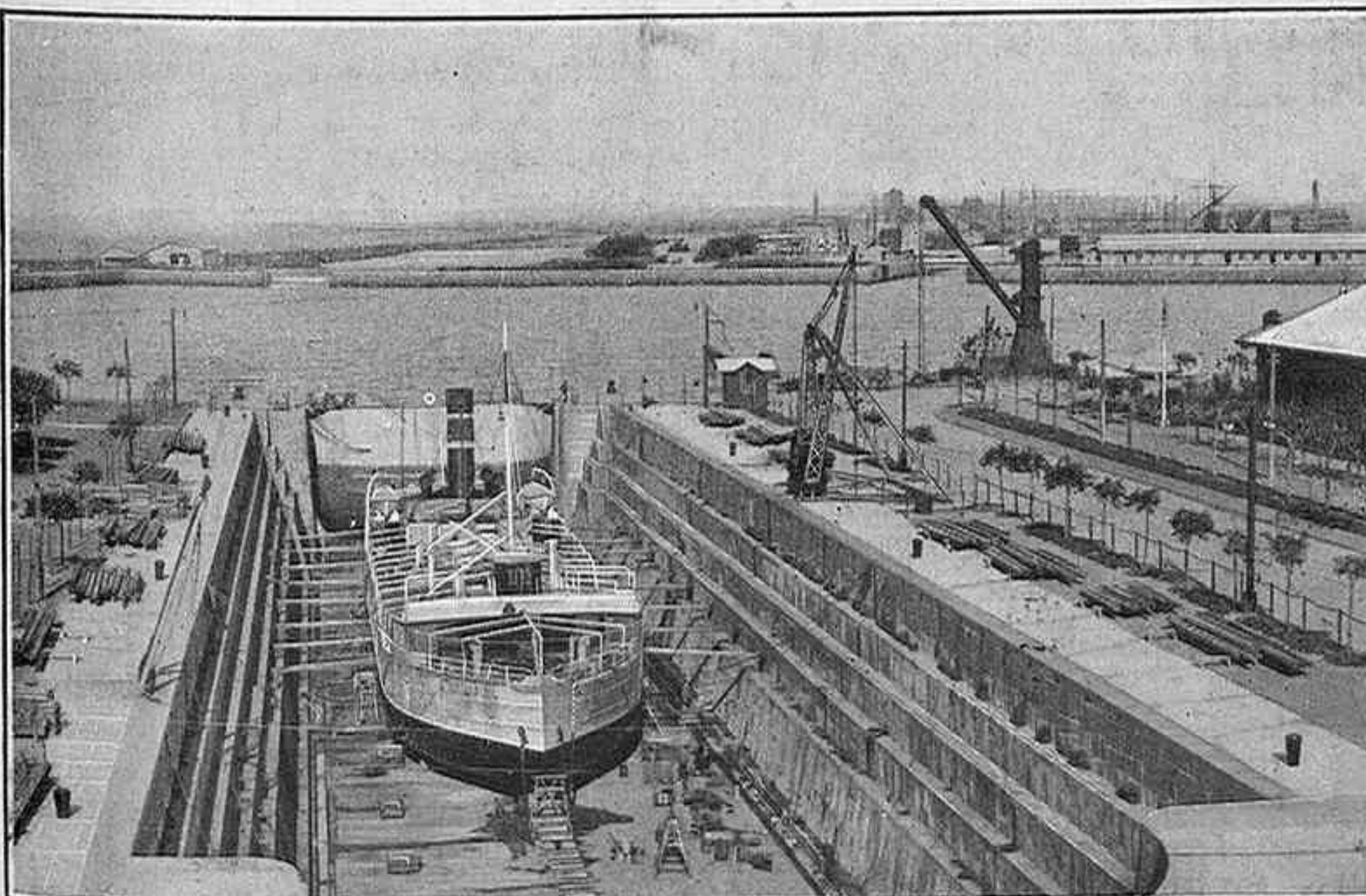
DIQUE DE CARENA DEL OESTE ESLORA 150 metros, MANGA 22 metros y 7'5 metros PUNTAL
