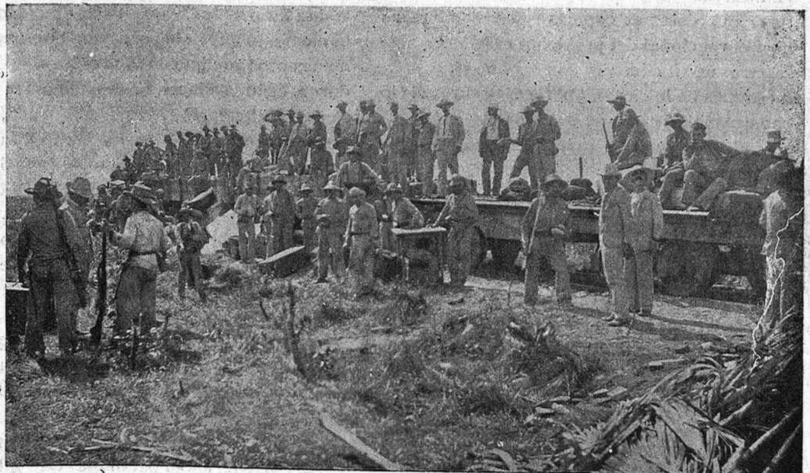
Trocha del Júcaro.—Embarque de cuadrillas para trasladarse de uno á otro punto de las obras.
