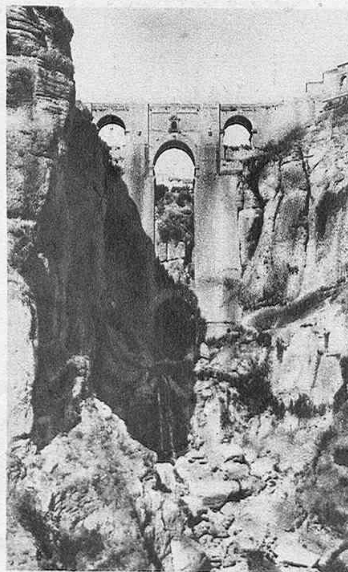
Puente nuevo, de noventa metros de altura, que, construido en 1735, se hundió á los seis años, y fué reedificado en 1793
