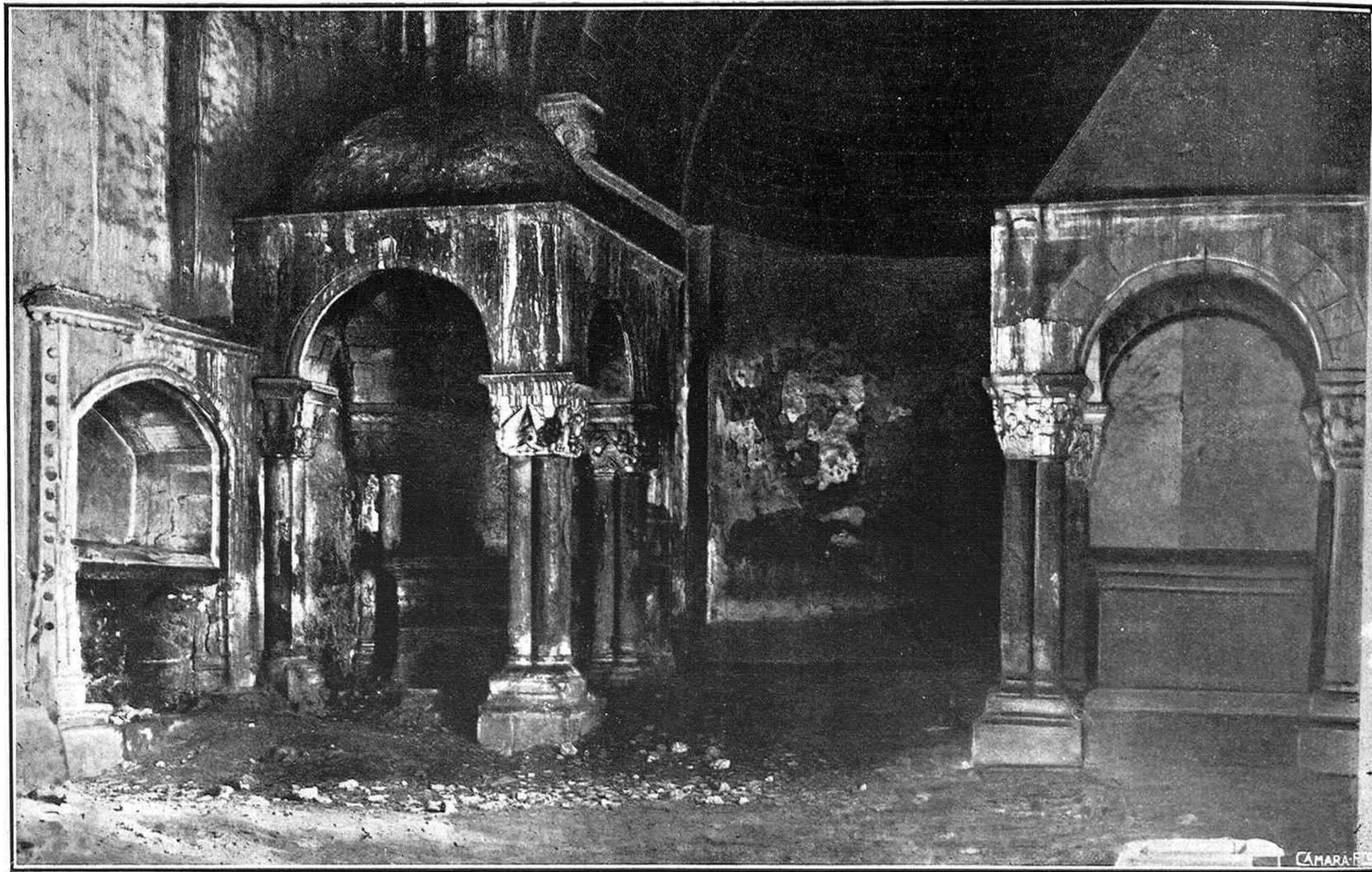
Interior de la iglesia
