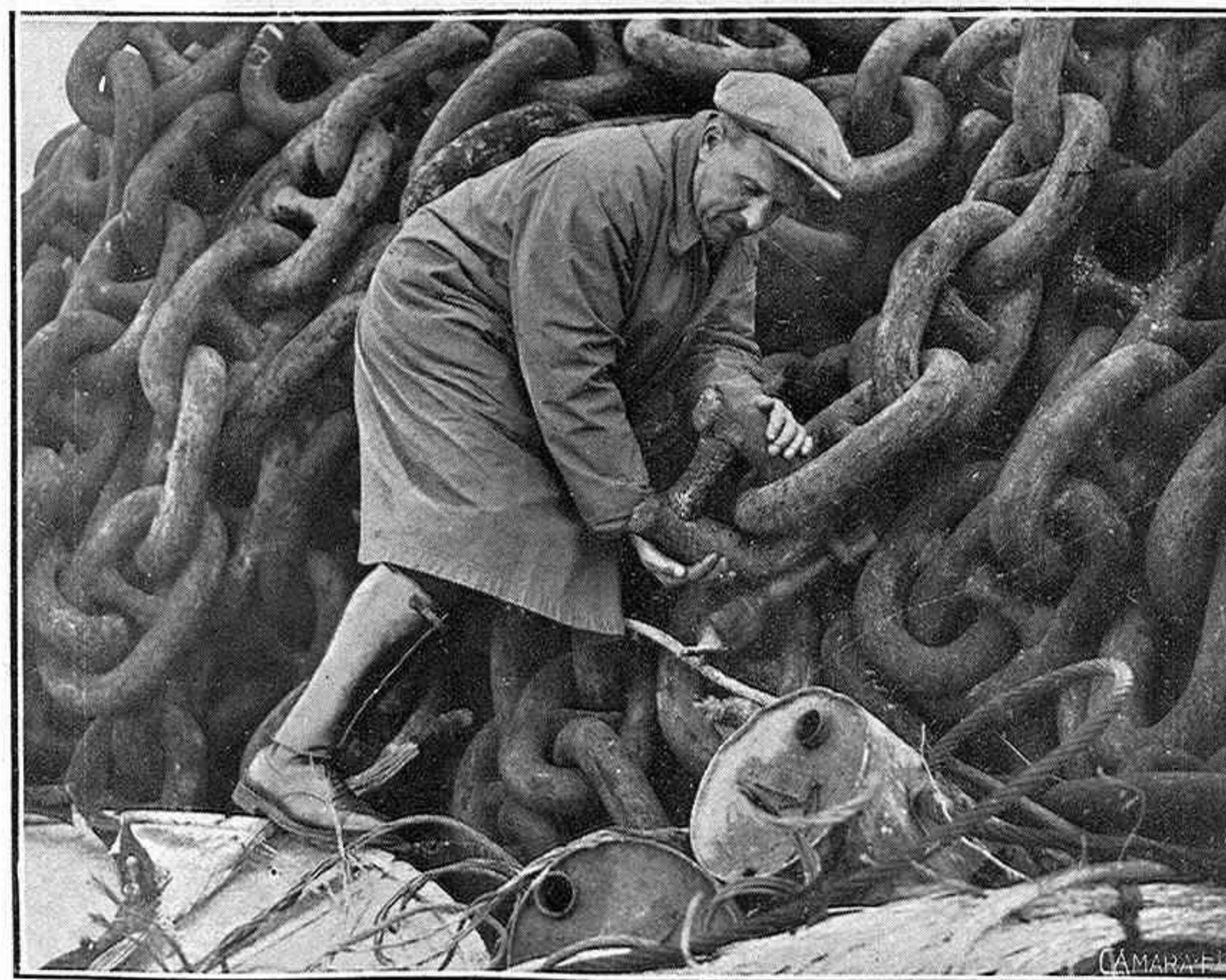
Cadenas empleadas en los primeros trabajos de salvamento de la flota hundida, y que no resistieron el peso de los buques
