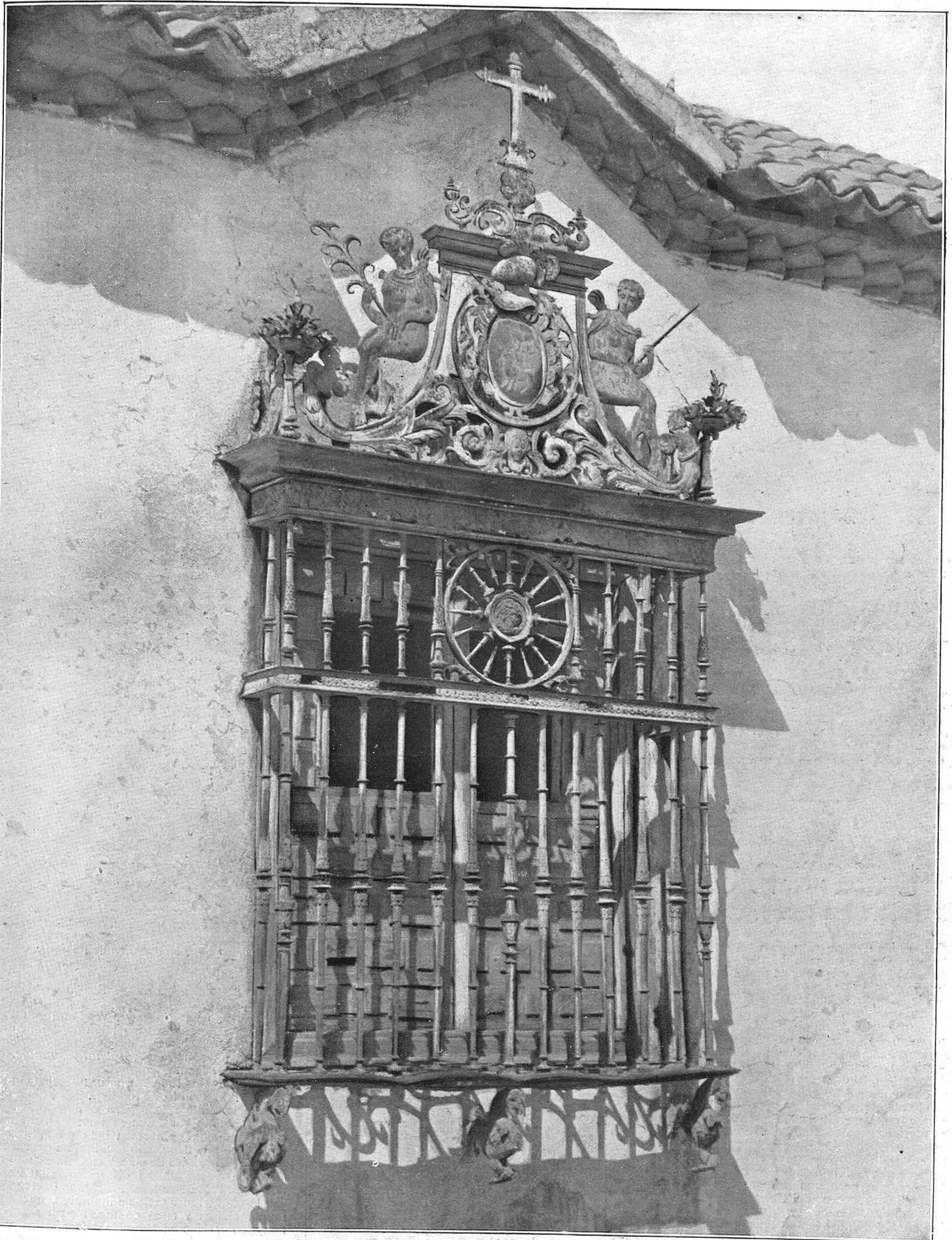
PRECIOSA REJA DE HIERRO DULCE REPUJADO DEL SIGLO XVI, DE GRAN MÉRITO ARTÍSTICO, EXISTENTE EN LA CASA SOLARIEGA DE LOS CONDES DE LA QUINTERÍA, EN ANDÚJAR (JAÉN)
