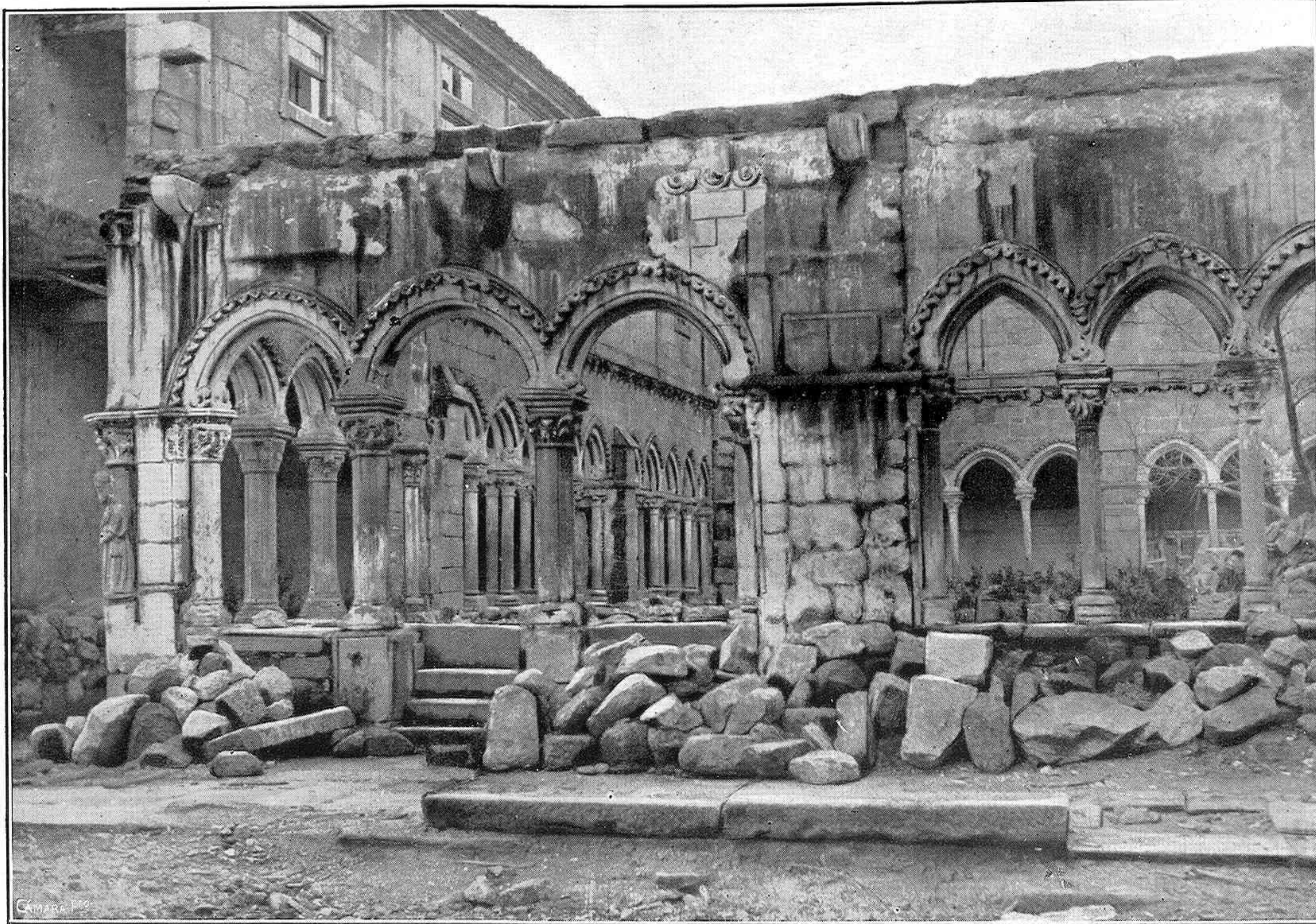
Ruinas del claustro del convento de San Francisco, en Orense
