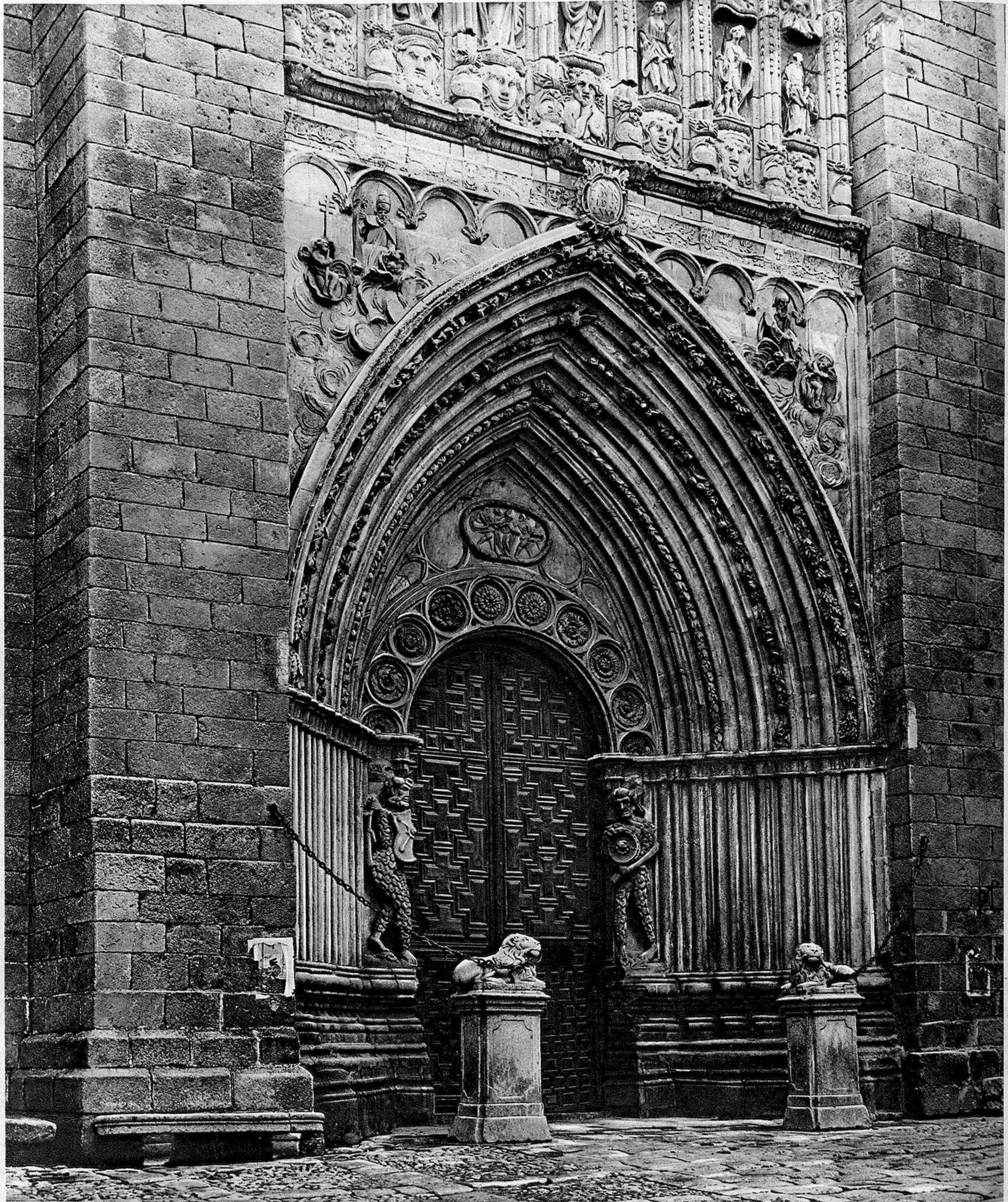
PUERTA DE ENTRADA Á LA CATEDRAL DE ÁVILA, ABIERTA ENTRE LAS DOS TORRES QUE LIMITAN LA FACHADA PRINCIPAL
