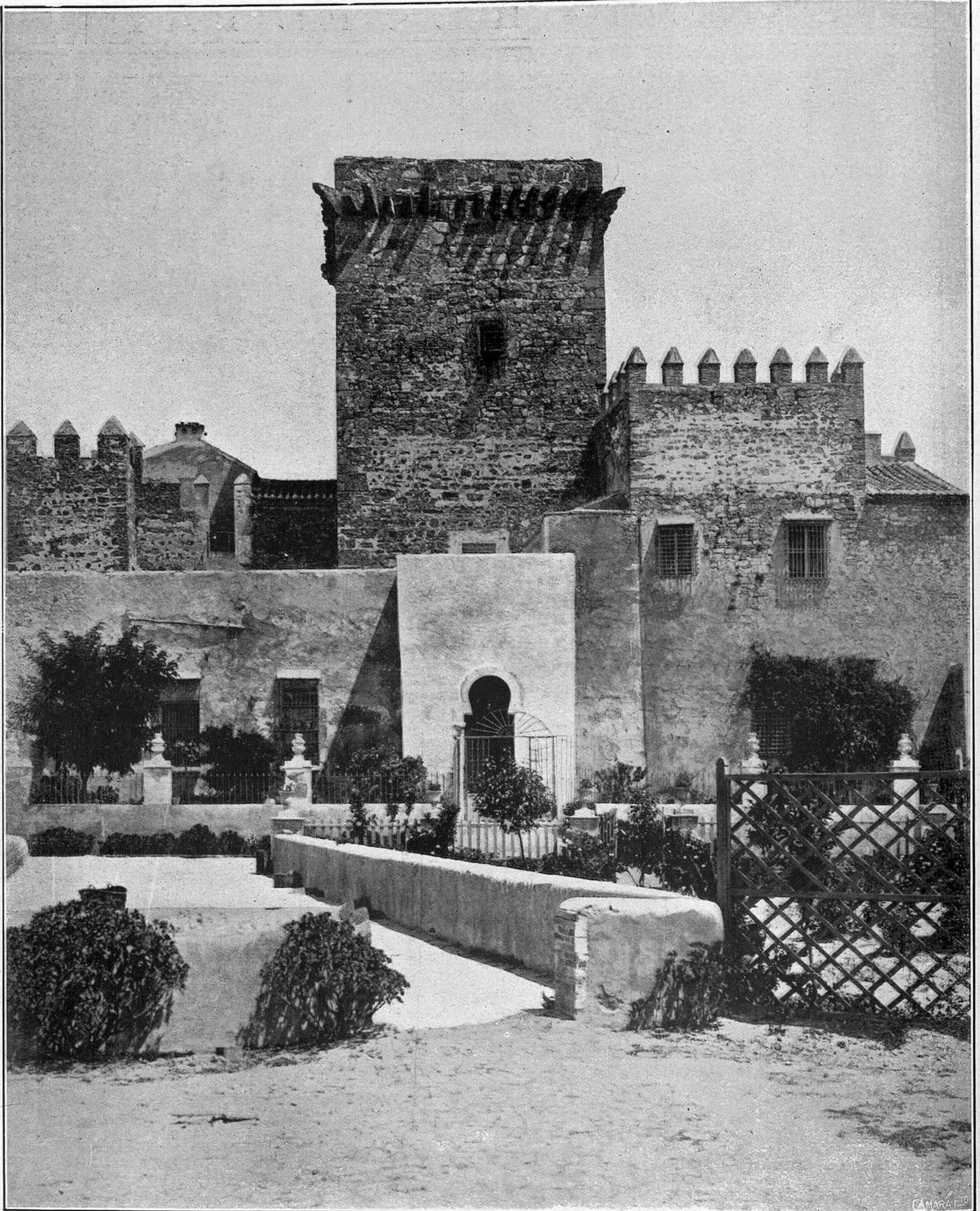
FACHADA Y TORREONES DEL FAMOSO CASTILLO EXISTENTE EN ESPEJO (CÓRDOBA)
