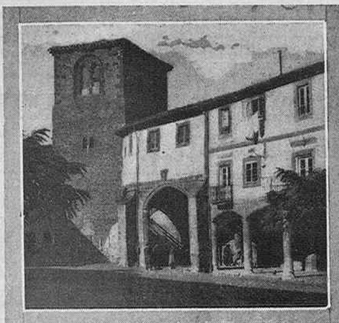
Torre de la iglesia de San Juan, edificada en el siglo XII
