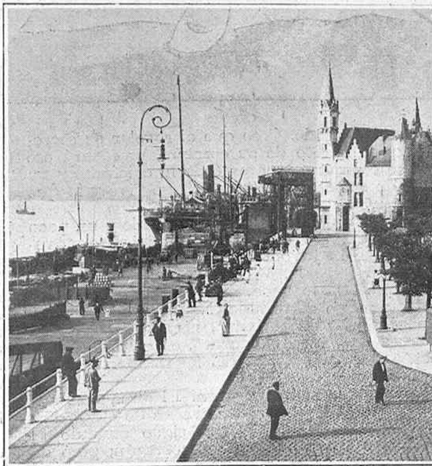
Detalle del puerto de Amberes, que muestra el fuerte contraste de la pintoresca ciudad histórica con el tráfico de la vida moderna
