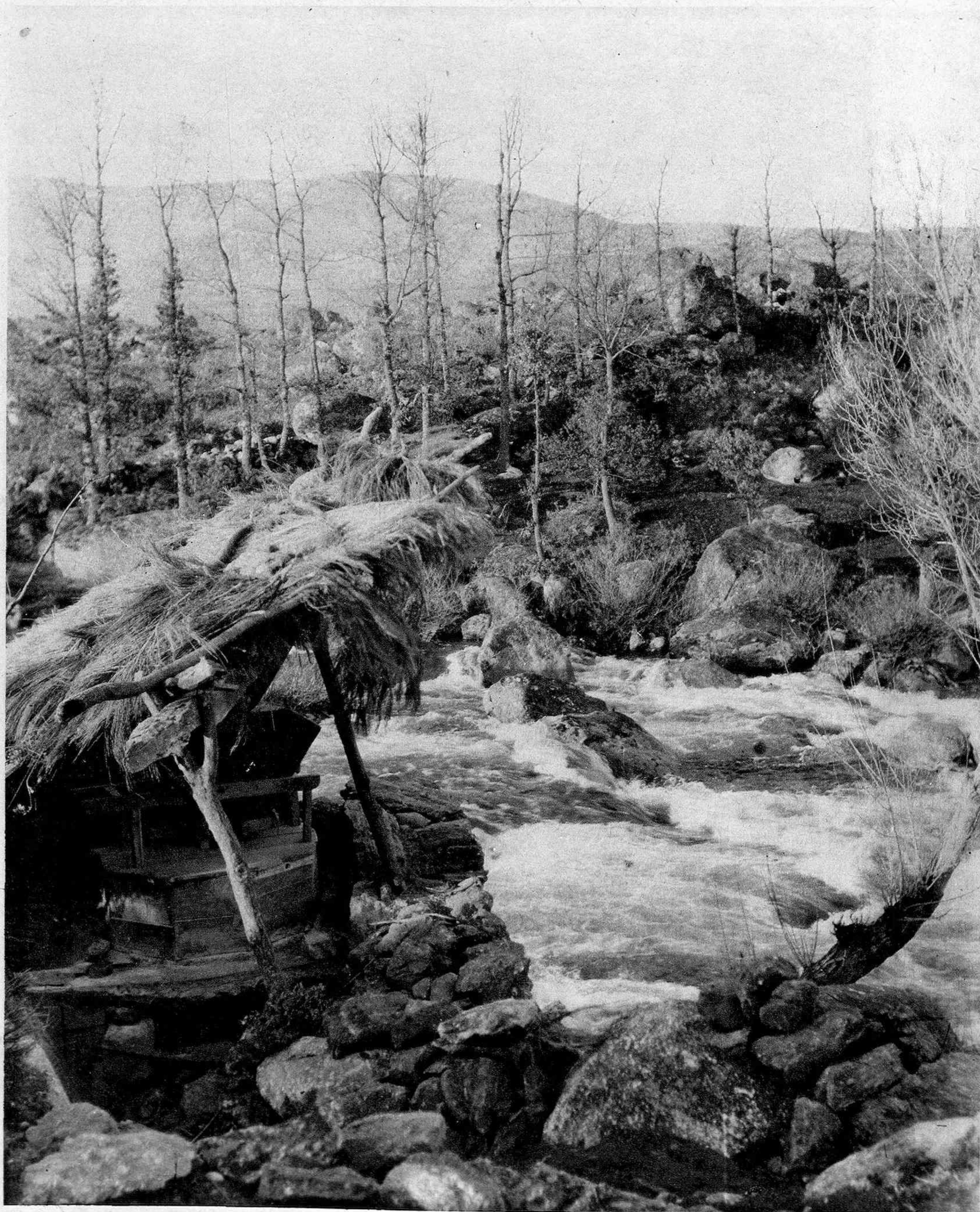
Un molino primitivo en el desagüe de la laguna de Puebla de Sanabria
