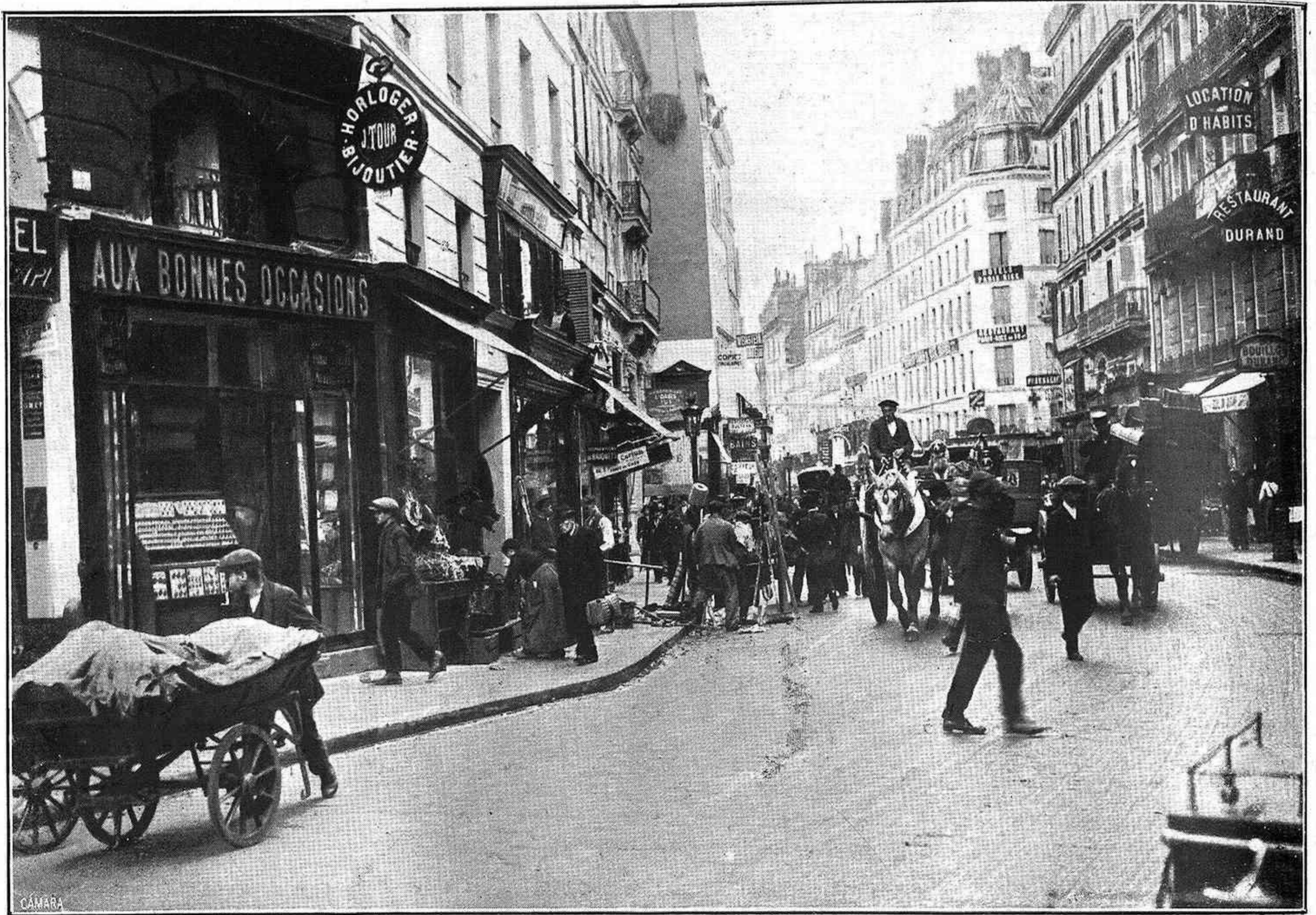
Tenderetes y vendedores ambulantes que dificultan el tránsito por las aceras en el Faubourg Montmartre
