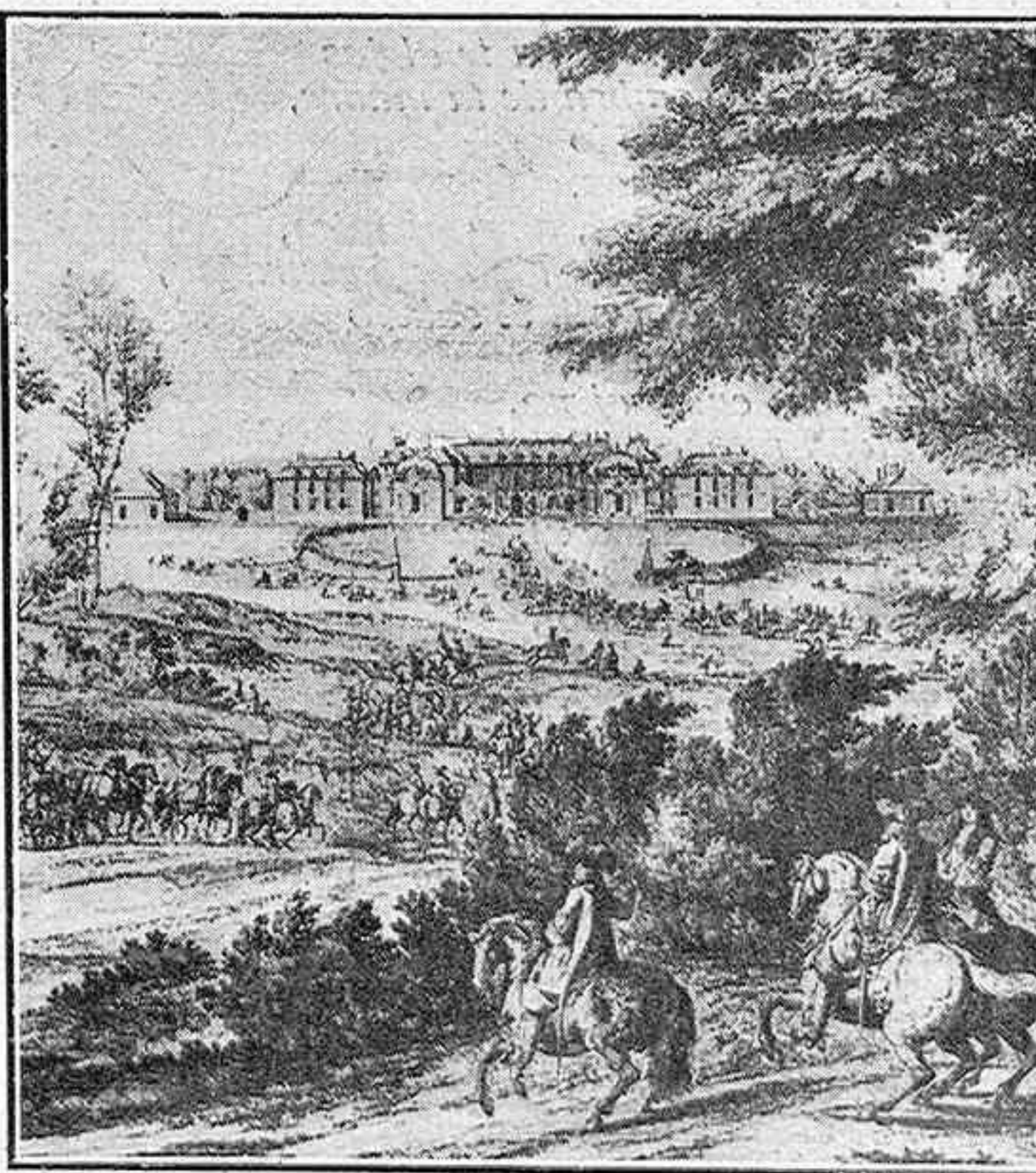
Pabellón de Caza, construido por Luis XIII
