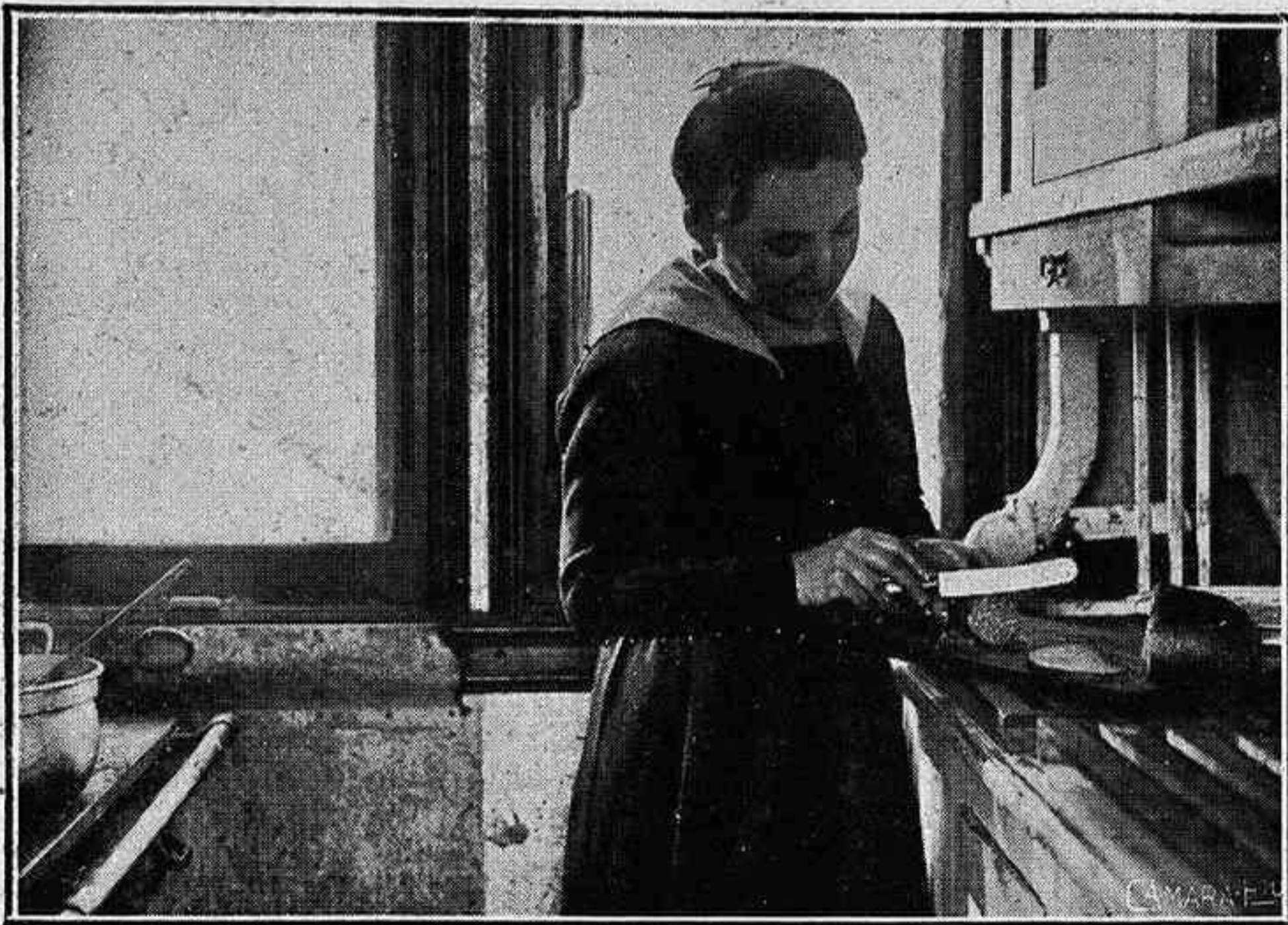
Aspecto de la cocina de una casa-vagón
