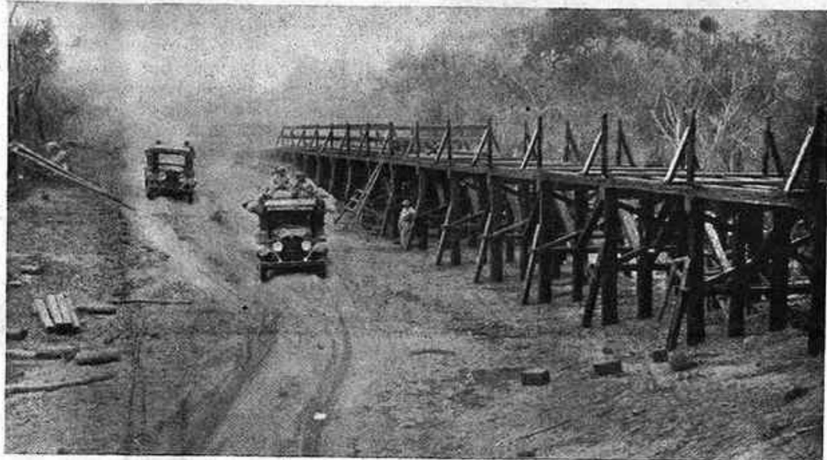
Pont en construcció per a l'època de les pluges
