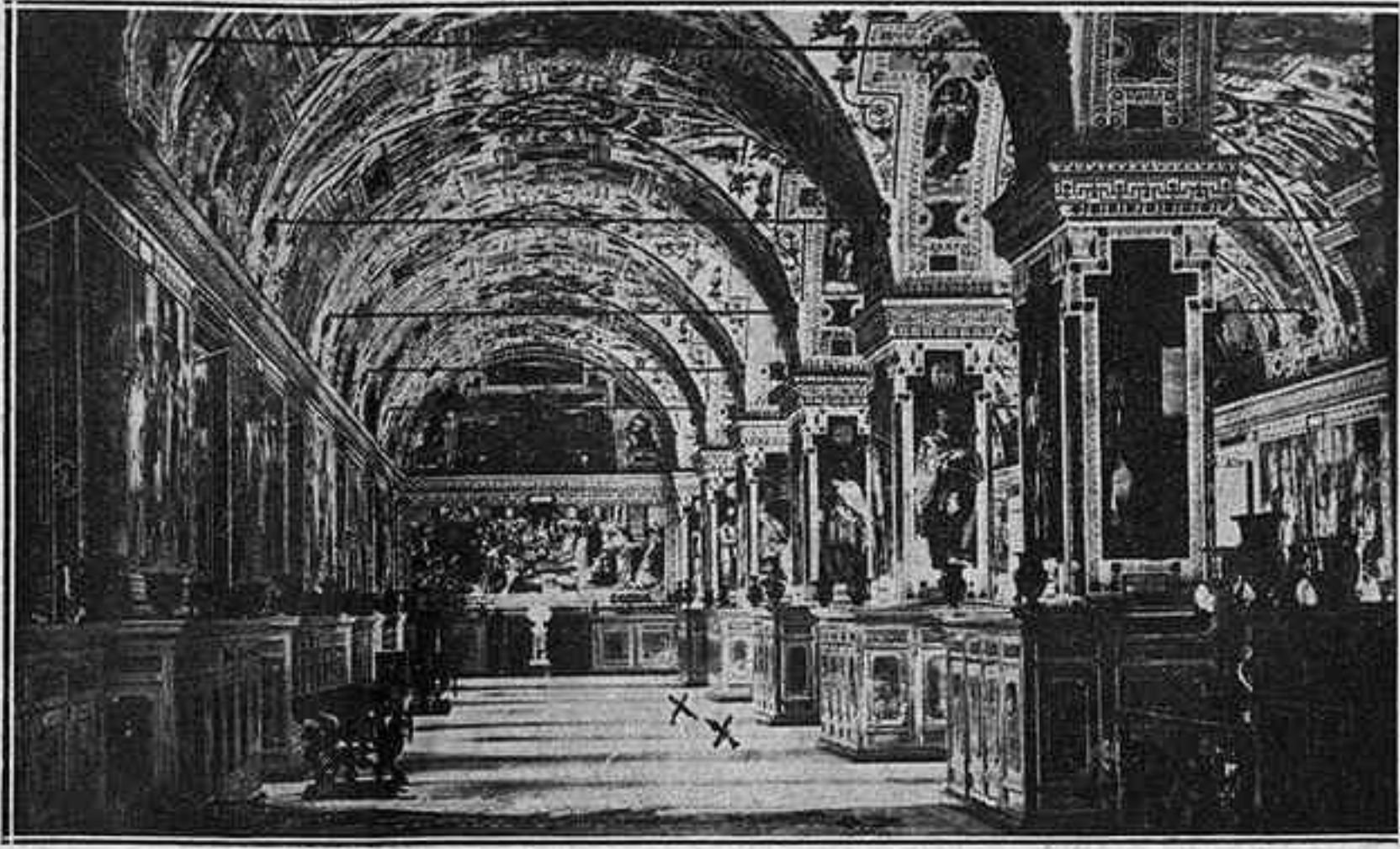
La sala Sixtina. Els pilars marcats amb una creu són els que s'han ensorrat
