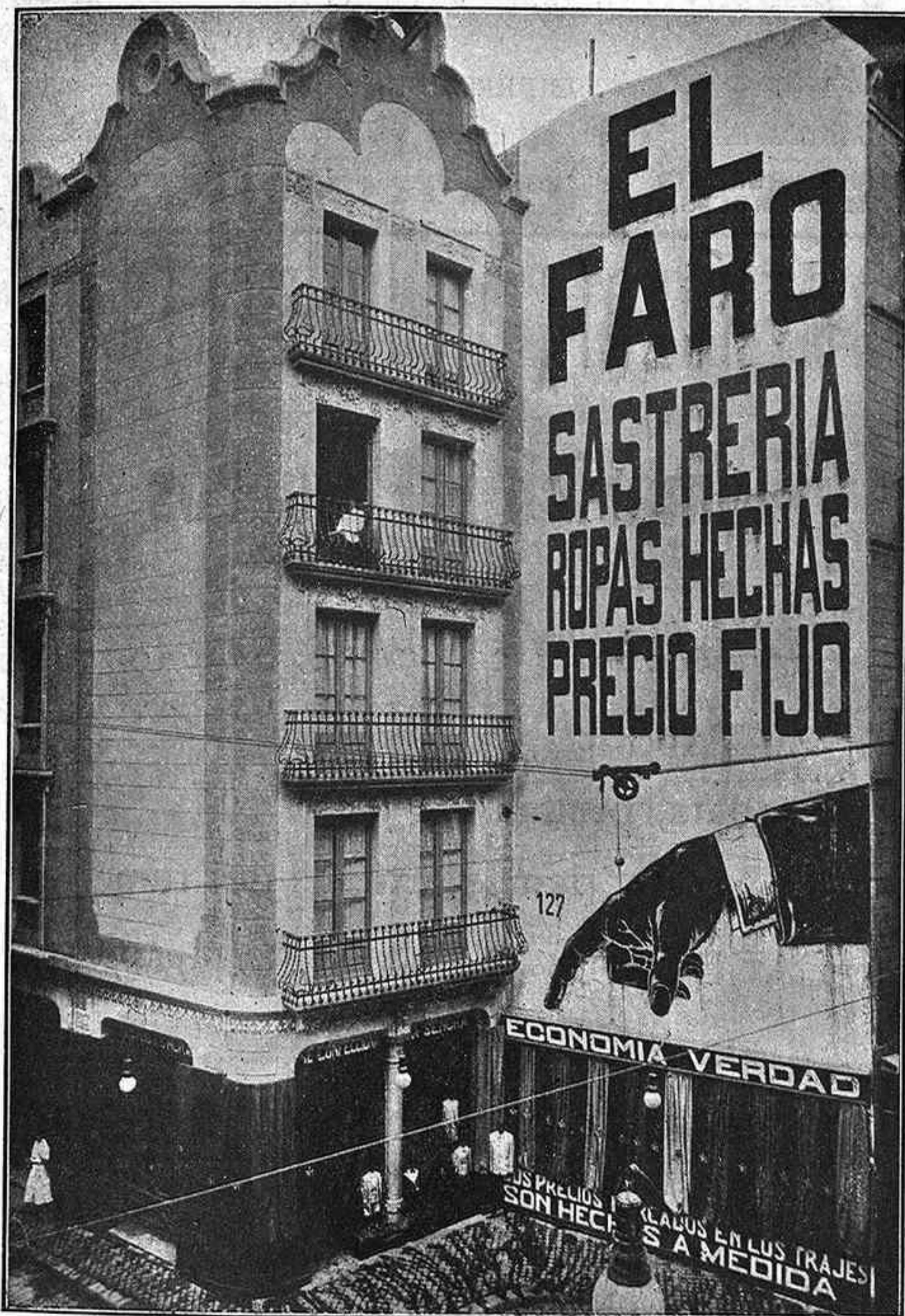
Fachada Hospital, 127, BARCELONA ESQUINA SAN JERÓNIMO, 2
