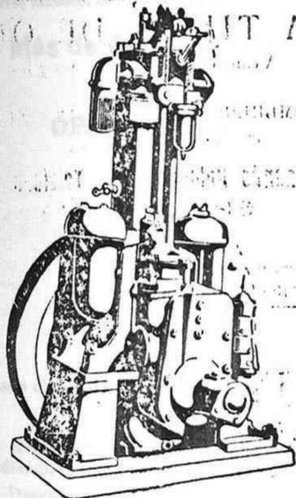
Motores Diesel a cuatro tiempos «REFORM»
