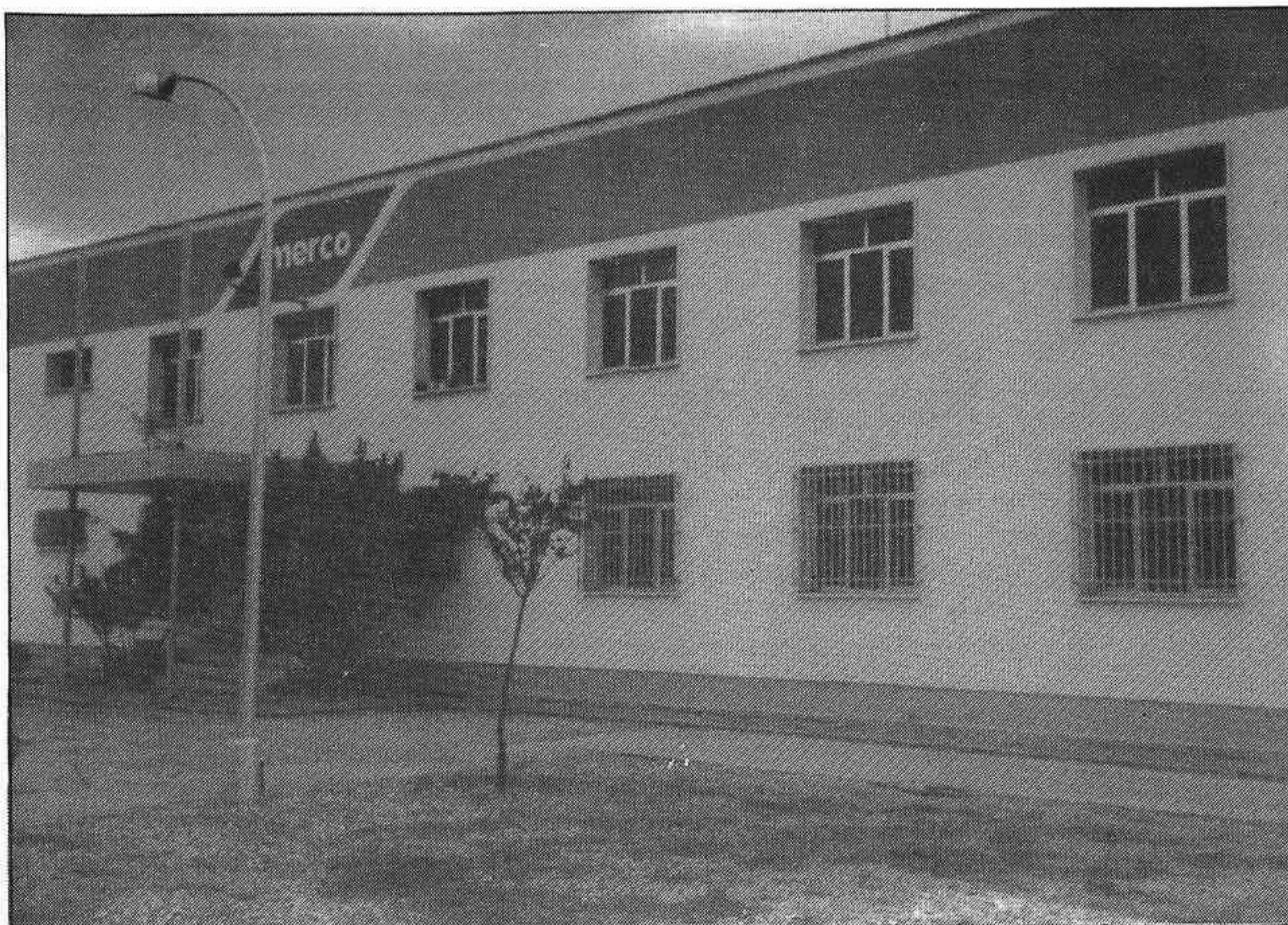
Fachada principal del edificio MERCOCENTRO, adquirido por APAG - COAGRAL
