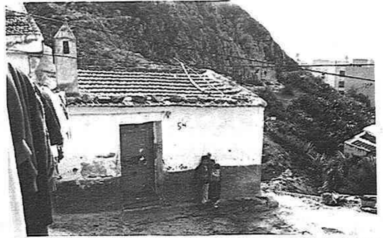
Nº16.- Esta casa sin ventanas en la fachada se halla al final de la calle Castillo en la vertiente del barranco que nace cerca del Seminario. No tiene desagüe y sus aguas fecales van al barranco.
