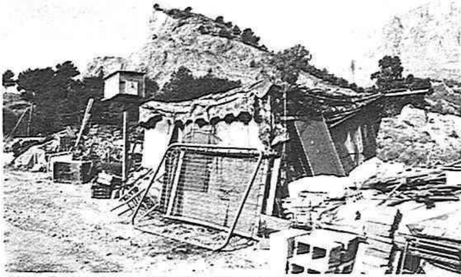
Nº9.- Bº San Antón. Subida a Canteras. Chabola con palomar, basuras, trastos, ladrillos con el fin de mejorarla con el tiempo.
