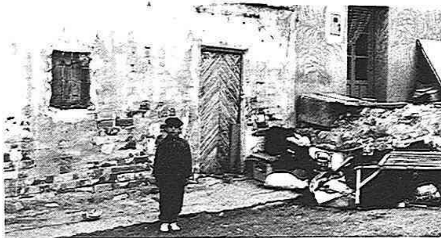
Nº3.- Barrio de San Antón. C/ San Antón. Sin luz ni agua, etc.
