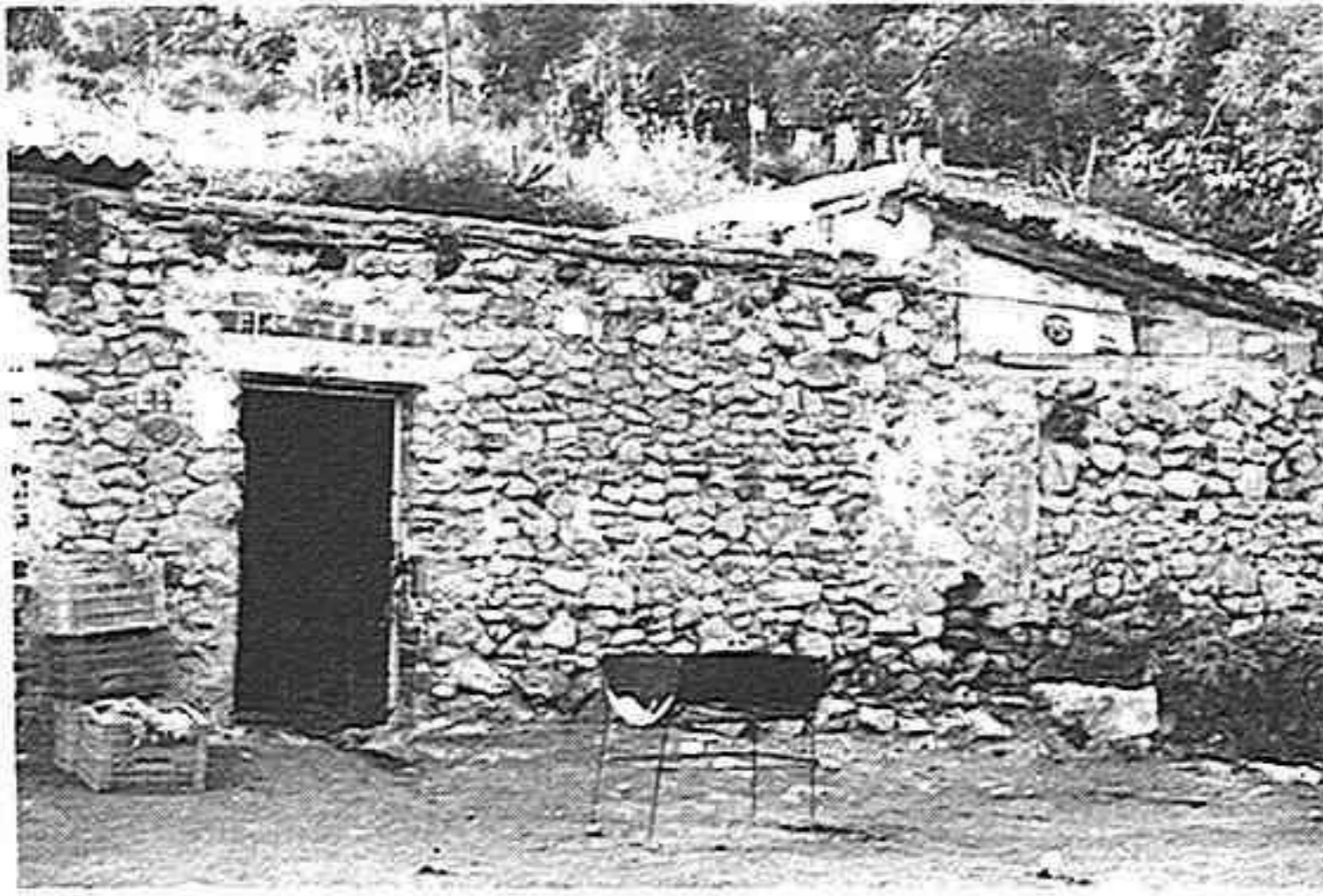
Nº7.- Bº San Antón. Casa inhabitable en la C/ San Antón. La siguiente está casi en las mismas condiciones y viven en ella.
