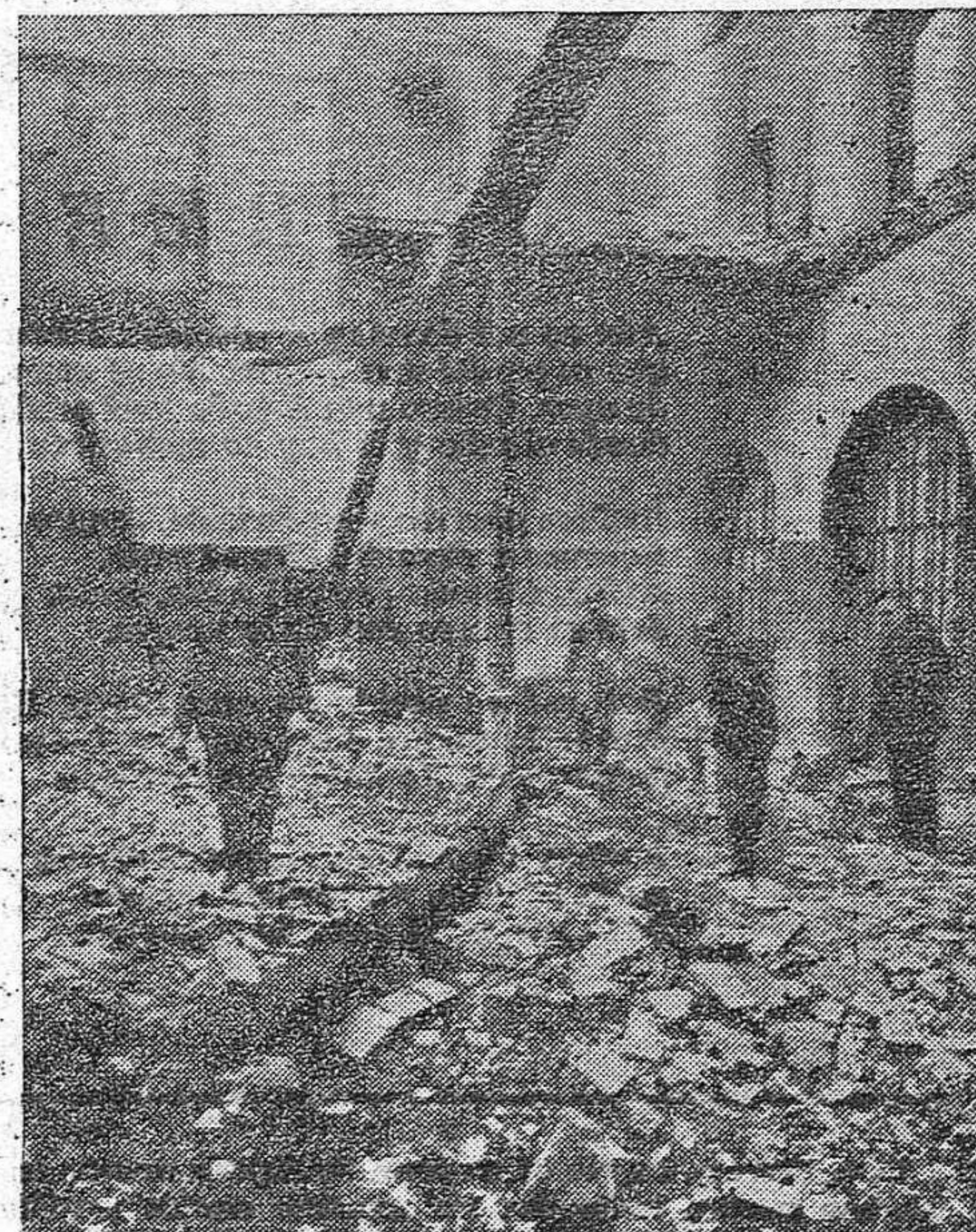
Un incendio, al parecer provocado por un cortocircuito en la techumbre del edificio, destruyó en la noche del 27 de enero la estación ferroviaria del Norte, en La Coruña. El fuego se propagó rápidamente, destruyendo todo el edificio que constaba de planta baja y dos pisos, era de construcción antigua. Las columnas que eran de madera de tea, ardió inmediatamente, propagando el fuego a todo el edificio. La estación, había sido inaugurada el 10 de septiembre de 1883. Hace años había dejado de ser utilizada para el servicio de viajeros, y últimamente volvió nuevamente a ser empleada en ello. Las pérdidas se calculan en diez millones de pesetas. La foto recoge un aspecto de cómo quedó el edificio cuando aún estaban trabajando los bomberos.
