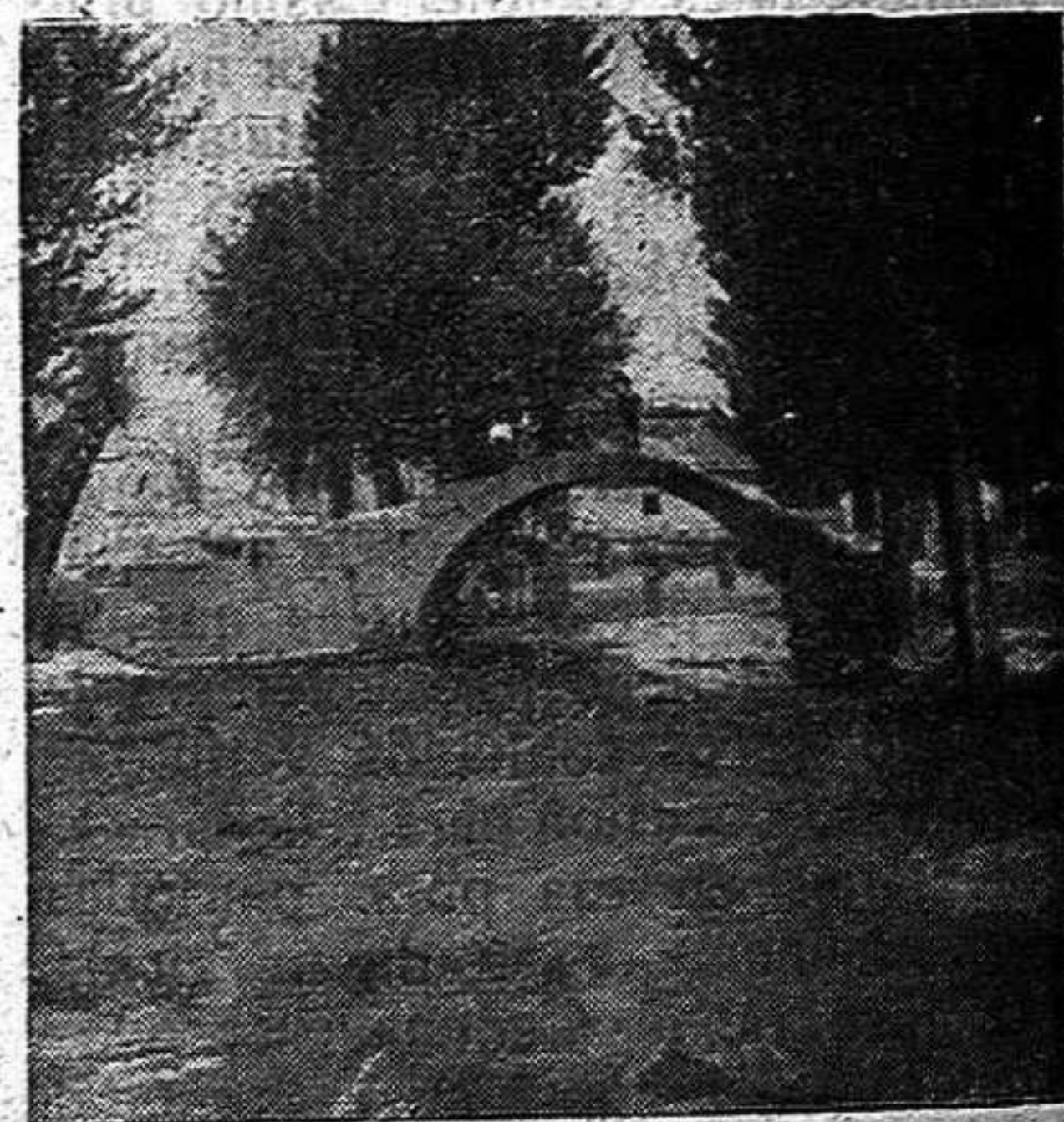
Antiguo puente romano
