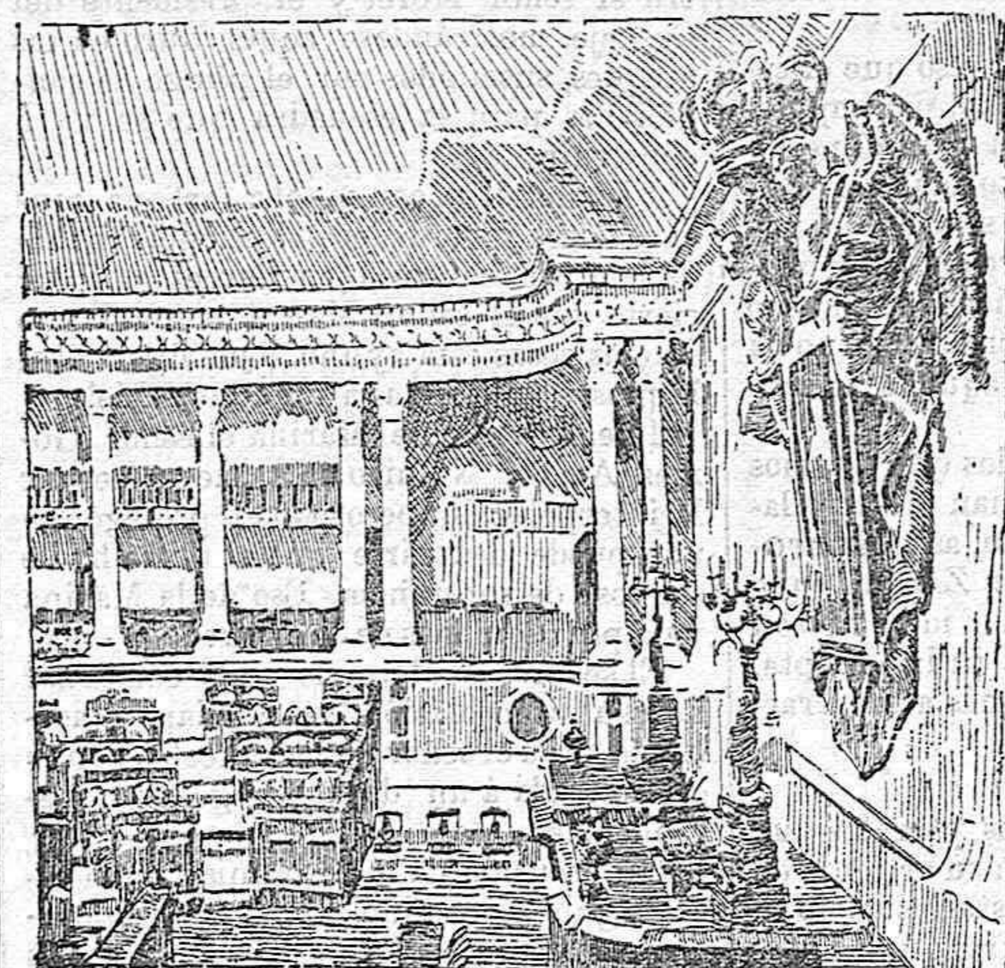
Residencia del Parlamento portugués, donde S. M. el rey don Manuel II, ha jurado guardar la Constitución.
