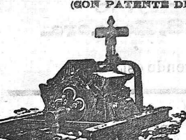
Nuevo aparato perfeccionado para extraer agua, aprovechando los arcaduces hasta la última gota del líquido, y con el más pequeño es-fuerzo de las caballerías, por la disposición de la artesa ypor la suavi-dad de los rozamientos montados sobre armadura de cilindros.
