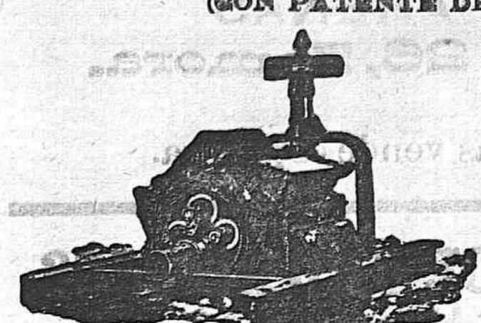
Nuevo aparato perfeccionado paza extraer agua, aprovechando los arcaduces hasta la última gota del líquido, y con el más pequeño es-fuerzo de las caballerías, por la disposición de la artesa ypor la suavi-dad de los rozamientos montados sobre armadura de cilindros.
