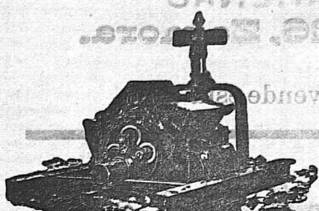
Nuevo aparato perfeccionado para extraer agua, aprovechando los arcaduces hasta la última gota del líquido, y con el más pequeño es-fuerzo de las caballerías, por la disposición de la artesa ypor la suavi-dad de los rozamientos montados sobre armadura de cilindros.
