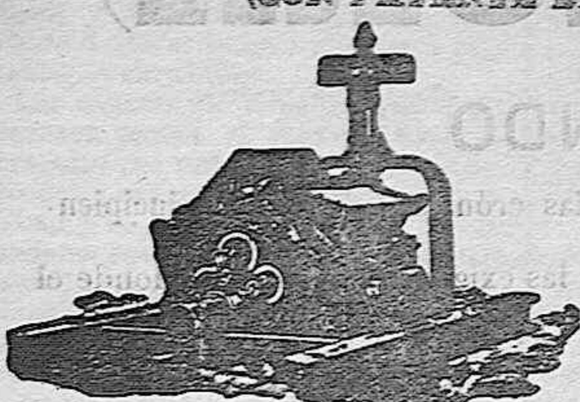
Nuevo aparato perfeccionado para extraer agua, aprovechando los arreudos hasta la última gota del líquido, y con el más pequeño esfuerzo de las caballerías, por la disposición de las artesas y por la suavidad de los rodamientos montados sobre armadura de cilindros.
