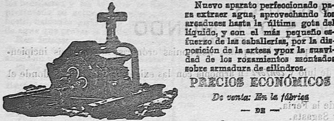
Nuevo aparato perfeccionado para extraer agua, aprovechando los arroyos hasta la última gota del líquido, y con el más pequeño esfuerzo de las caballerías, por la disposición de la artesa y por la suavidad de los rozamientos montados sobre armadura de cilindros.
