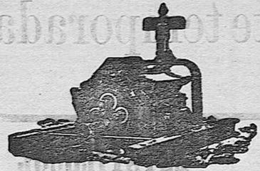
Nuevo aparato perfeccionado para extraer agua, aprovechando los araduces hasta la última gota del líquido, y con el más pequeño esfuerzo de las caballerías, por la disposición de la arca y por la suavidad de los rozamientos montados sobre armadura de cilindros.
