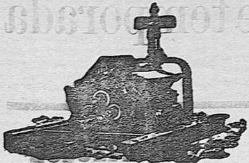
Nuevo aparato perfeccionado para extraer agua, aprovechando los arcaños hasta la última gota del líquido, y con el más pequeño esfuerzo de las caballerías, por la disposición de la arcaña y por la suavidad de los rozamientos montados sobre armadura de cilindros.
